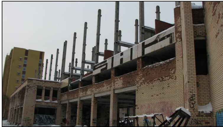
Рисунок 4. – Общий вид обследуемого объекта по оси «А»
