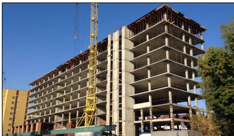
Рисунок 9. – Объект на стадии реконструкции (сентябрь 2015 года)
