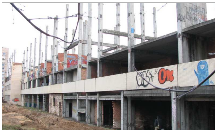
Рисунок 3. – Общий вид обследуемого объекта по оси «Е»
