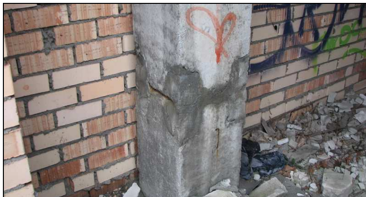
Рисунок 6. – Стык сборных железобетонных многоэтажных колонн
