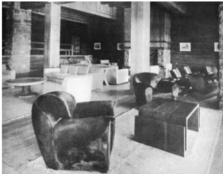
Figura 8: Hotel Llao-Llao. Hall principal. Vista del mismo ambiente desde el extremo opuesto. En primer plano, los sillones tapizados en cuero de vaca negro y la mesa revistero referida. Fuente: MOP, Síntesis de la obra efectuada 1932-1938, vol. II, División III, Dirección de Parques Nacionales, 1938, pp. 235-296.
