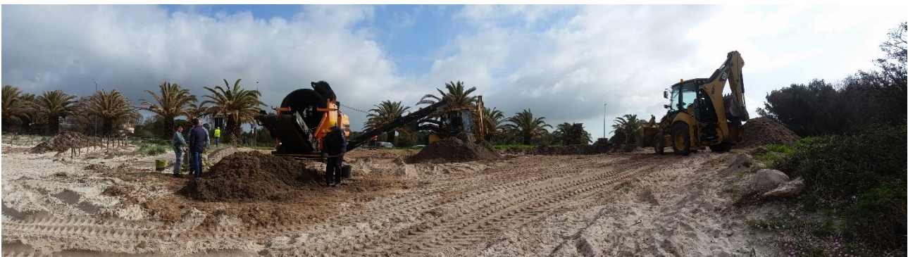
Figura 84 - Cantiere per la vagliatura dell'accumulo della Posidonia spiaggiata di Villa Segni (da destra): pala meccanica per la mobilizzazione dei depositi del sito; pala meccanica per caricare i depositi puliti dai rifiuti solidi urbani nel vaglio; vaglio; cumulo di materiale biogenica (in primo piano); cumulo di materiale clastico (in secondo piano)
