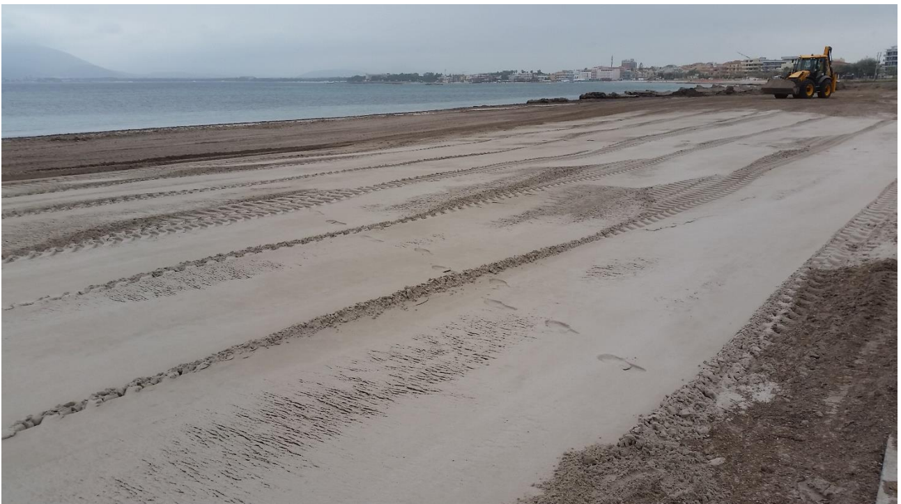
Figura 107 - Lavori di distribuzione della sabbia sull'arenile. La frazione scura è quella di sottovaglio. La frazione chiara quella derivata dalle operazioni di vagliatura in stabilimento della frazione di sopravaglio
