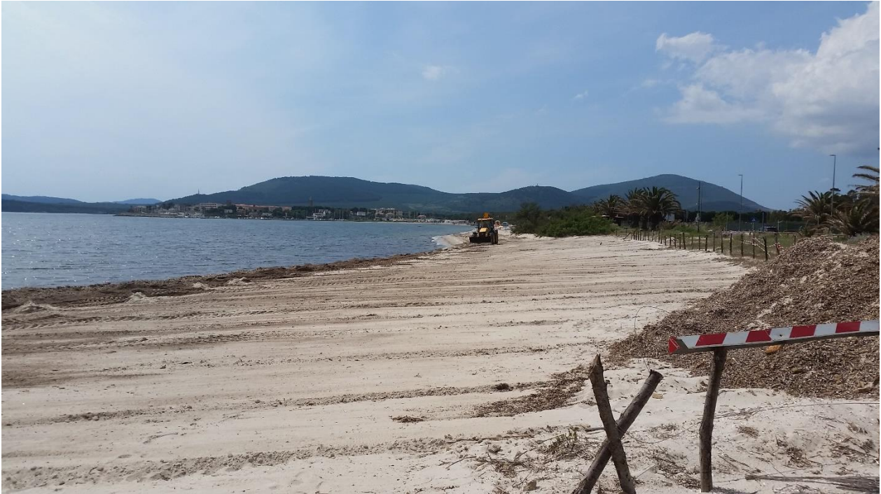
Figura 89 - Arenile durante il posizionamento della sabbia da vagliatura.
