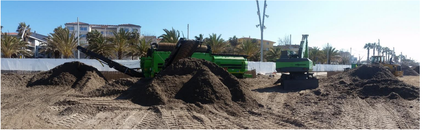
Figura 98 - Cantiere nel sito di San Giovanni. In primo piano la macchina vagliatrice (Doppstadt SM 518 PLUS), a destra il ragno ed infine la pala meccanica
