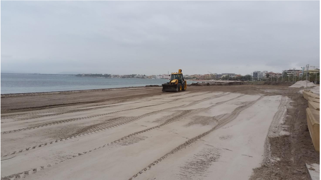
Figura 106 - Lavori di distribuzione della sabbia sull'arenile a seguito della rimozione degli accumuli di Posidonia. La frazione scura è quella di sottovaglio. La frazione chiara quella derivata dalle operazioni di vagliatura in stabilimento della frazione di sopravaglio
