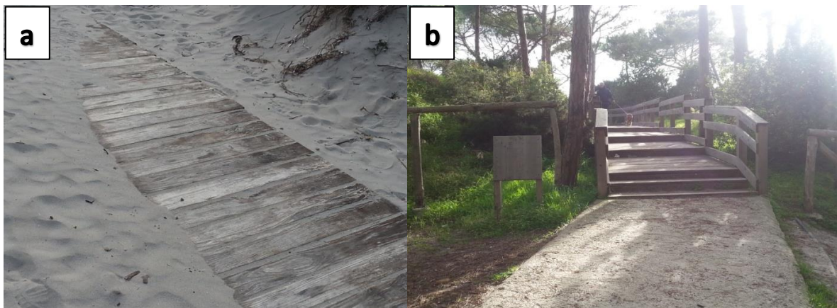
Figura 50 – a Passerella pedonale in legno rimovibile poggiate sulla sabbia, Maria Pia; b Passerella sopraelevata e pannello in legno per l'affissione di cartello informativo, Maria Pia.
