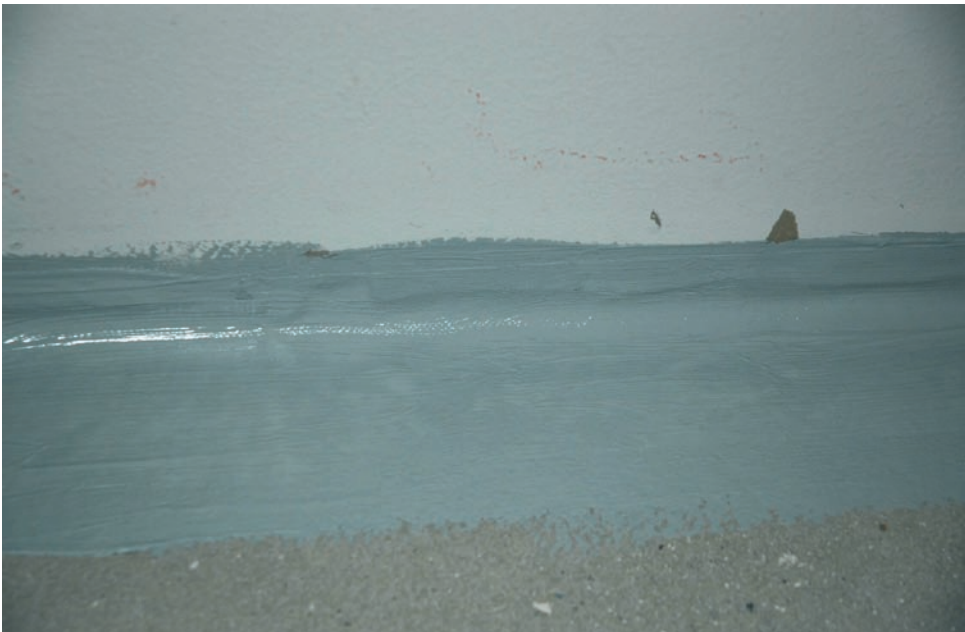
Bild 6.3 Tätning av läckande golvspringa med tätskikt och tätband.
