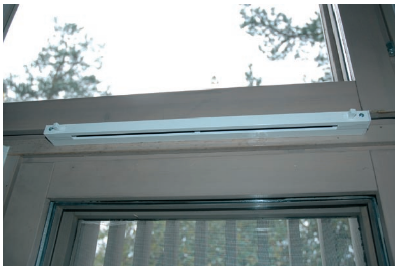
Bild 10.2 Spaltventil som installerats i fönsterkarmen.
