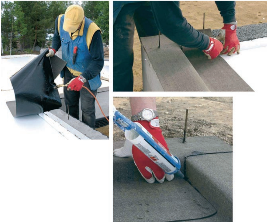
Bild 14.3. Montering av bitumentätskikt på grundmuren och tätning av hörnfogen. Foton: Katepal Oy.
