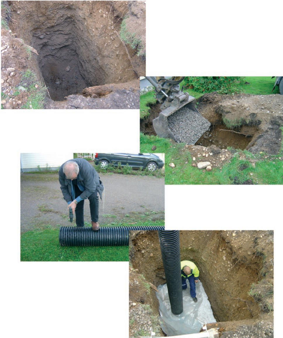
Bild 5.9. Schaktet för radonbrunnen, makadampåfyllning, borrning av hål i brunnsrörets nedre del samt utläggning av plastfolie på makadamen och filterduken.
