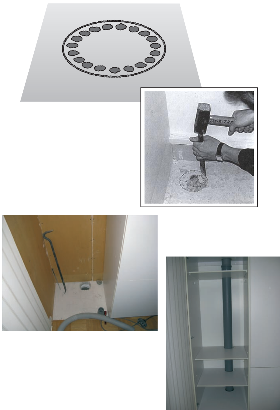
Bild 4.9. Hålet för genomföringen kan göras genom att borra hål i golvet och pikhugga upp hålet. (De två nedersta bilderna HT-Talo-Pojat Oy.)
