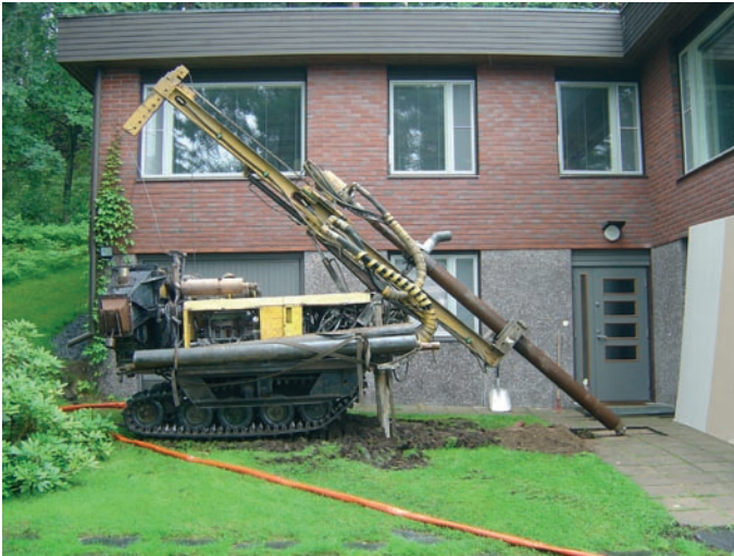
Bild 5.13 Borrbrunnstrustningen bredvid huset.
