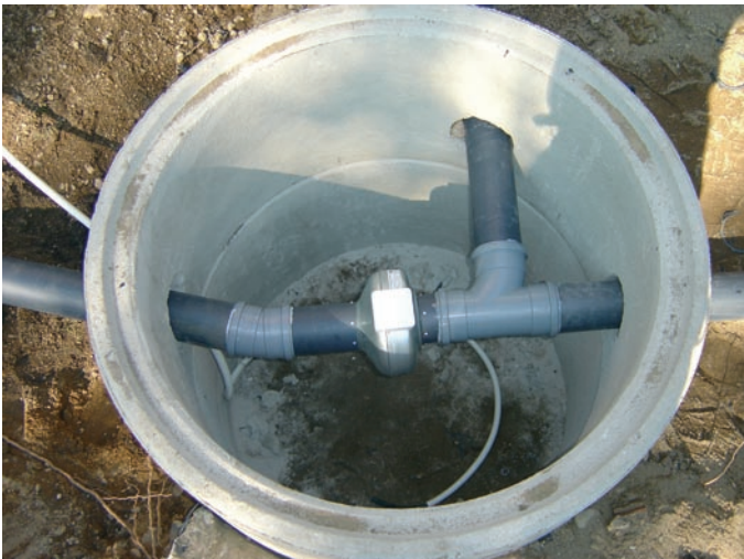
Bild 5.14 Sammanfogningen av två skilda sugningsförgreningar och kanalfläkten i brunnringen.
