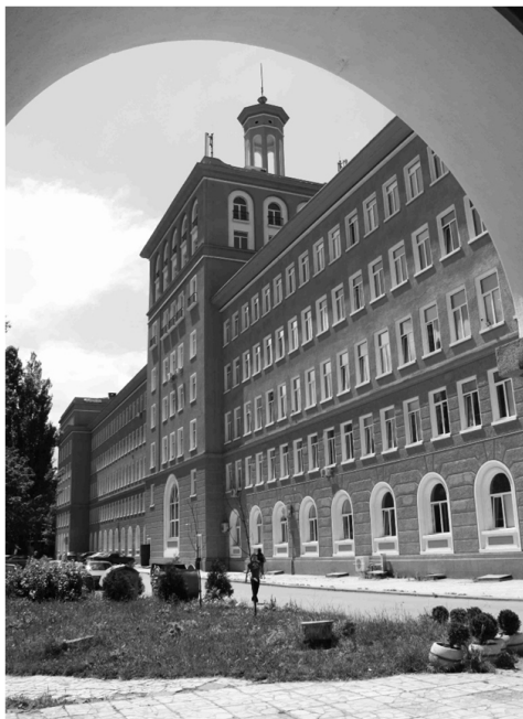
Abb. 9: Gebäude der Chemischen Fakultät der Universität Sofia (Foto 2009)
