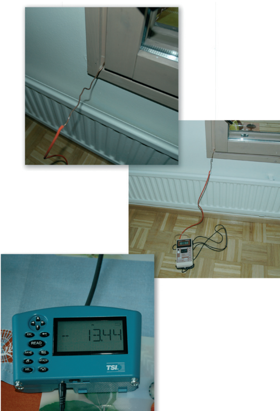
Kuva 12.2. Alipaineen mittaamiseen käytettäviä mikromanometrejä. Alipaine ulkoilmaan nähden mitataan ikkunan raosta kulkevan ohuen putken avulla.
