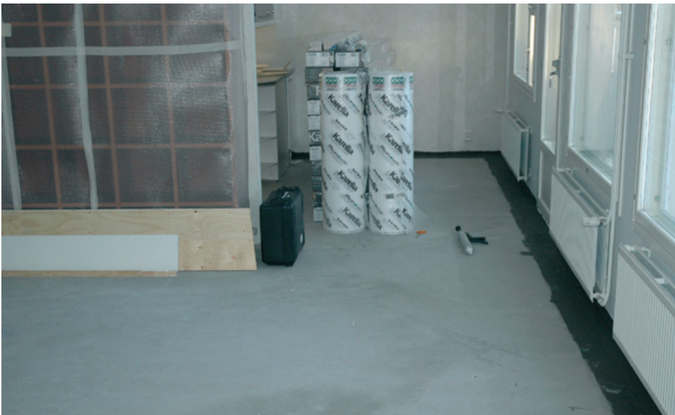
Kuva 6.6. Vedeneristysmassalla ja vahvikenauhalla suoritettu kaikkien lattiasaumojen tiivistäminen pientalokohteessa. Erittäin karkeiden täyttöainesten johdosta radonimuri ei toiminut kohteessa halutulla tavalla.
