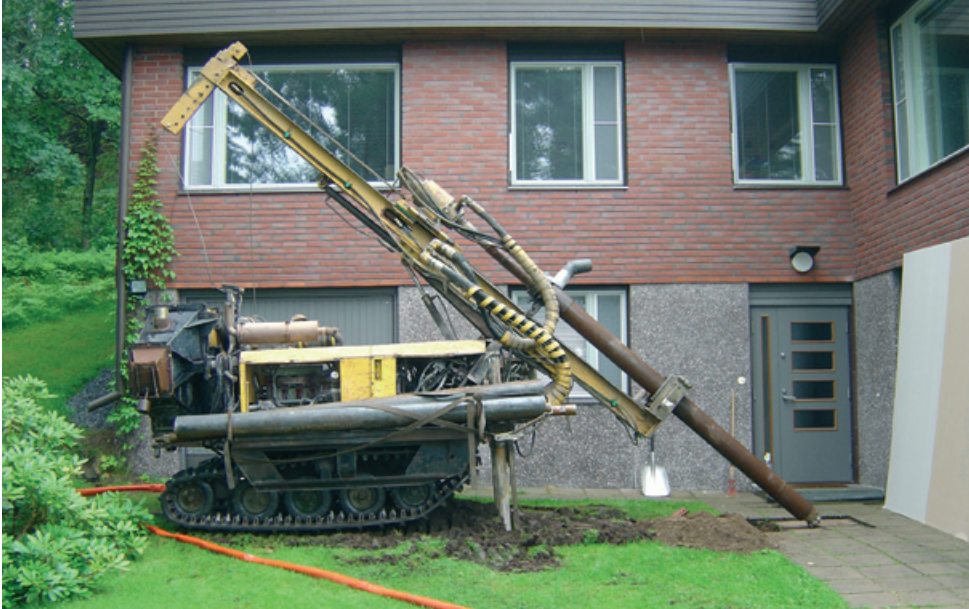
Kuva 5.13. Porakaivolaiteisto talon vierellä.
