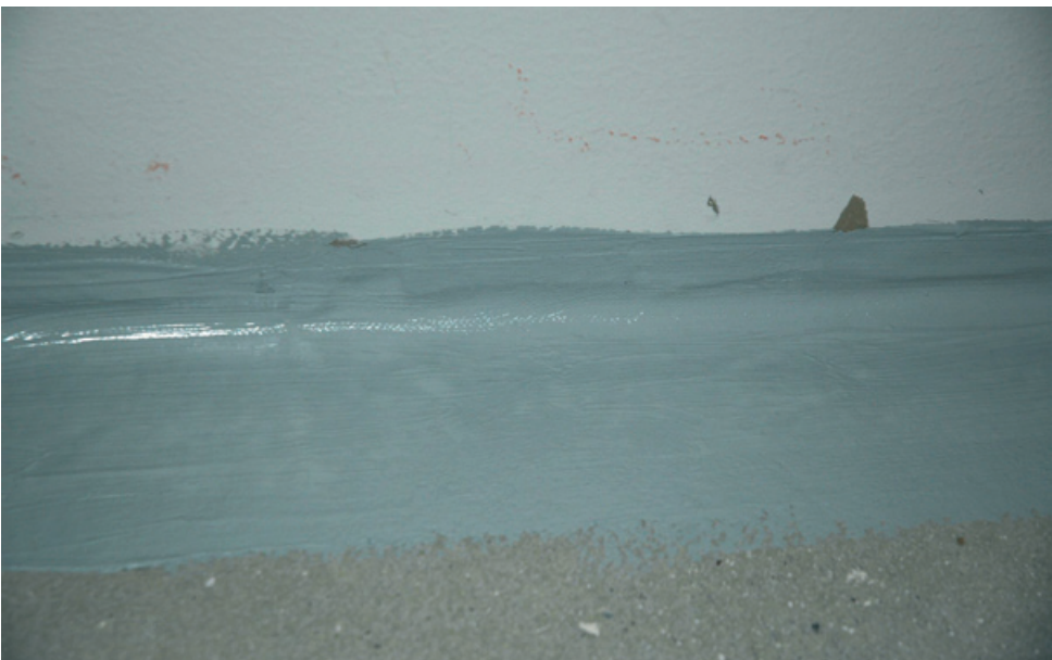
Kuva 6.4. Vuotavan lattiarakon tiivistäminen vedeneristysmassalla ja -nauhalla.
