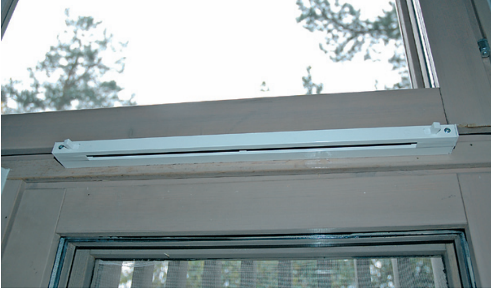
Kuva 10.2. Ikkunakarmiin asennettu rakoventtiili.
