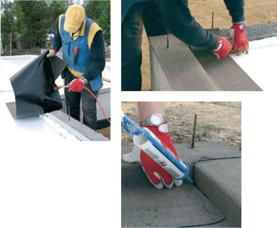
Kuva 14.3. Bitumikermin asentaminen perusmuurin päälle ja nurkkaliitoksen tiivistäminen. Kuvat: Katepal Oy.
