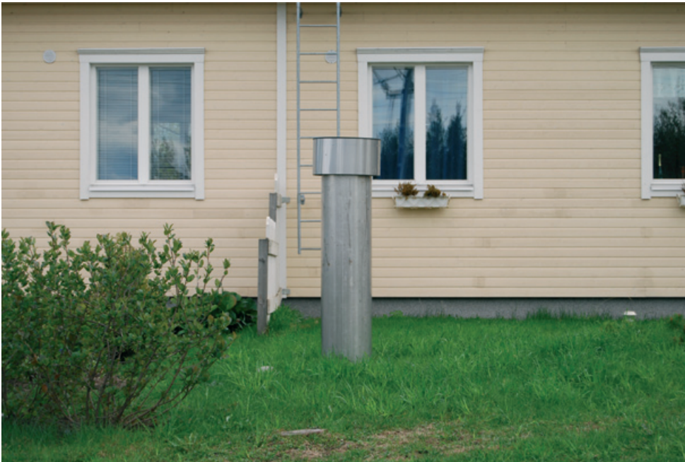
Kuva 5.8. Radonkaivon poistohormi Hyvinkäällä olevan paritalon pihalla.
