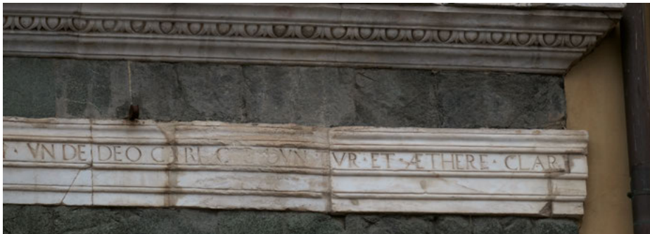
Abb. 12.1–7: Empoli, Sant'Andrea, Westfassade, Inschrift auf dem Architrav des Stockgesimses.
