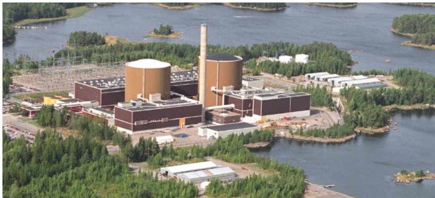
Kuva: Fortum Power and Heat Oy
