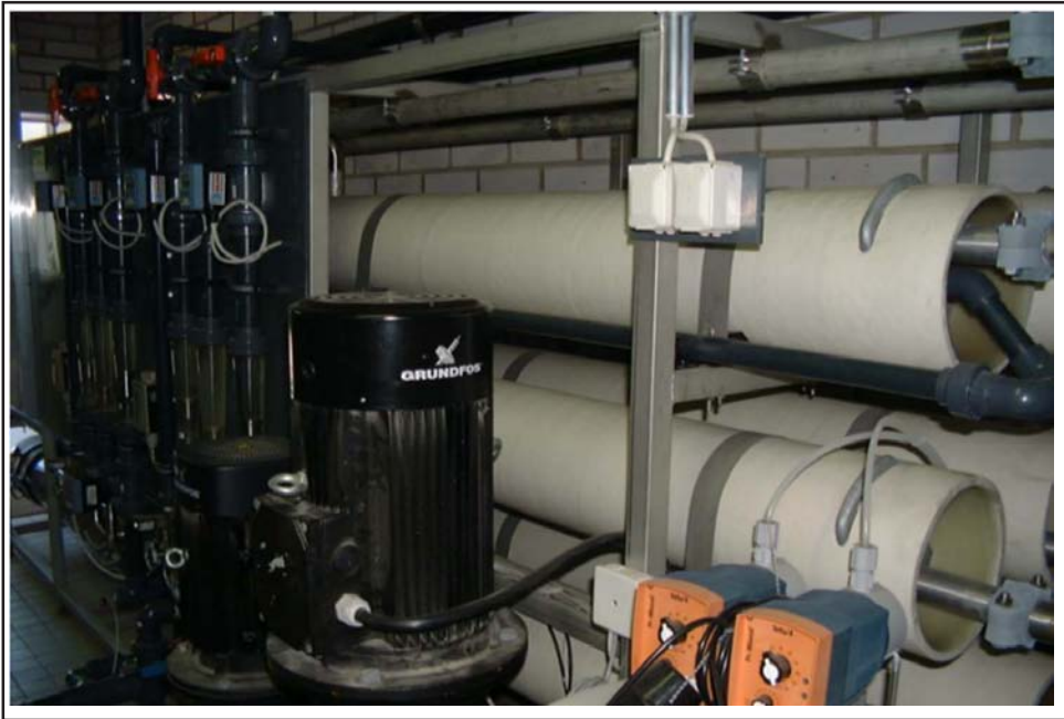
Kuva 4. Nanosuodatus ja käänteisosmoosi.
