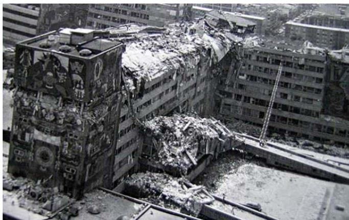
Figura 7. Colapso parcial del edificio SCT. (Nexos, 2017)
