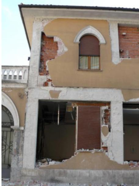
Figura 16. Vaciamiento de paneles de albañilería de relleno. (Oyarzo & Griffith, 2010)
