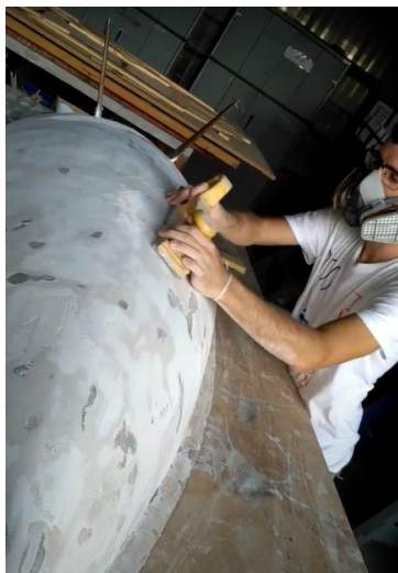
Figura 103. Aplicació de massilla i llimat a la superfície. Font: pròpia.
