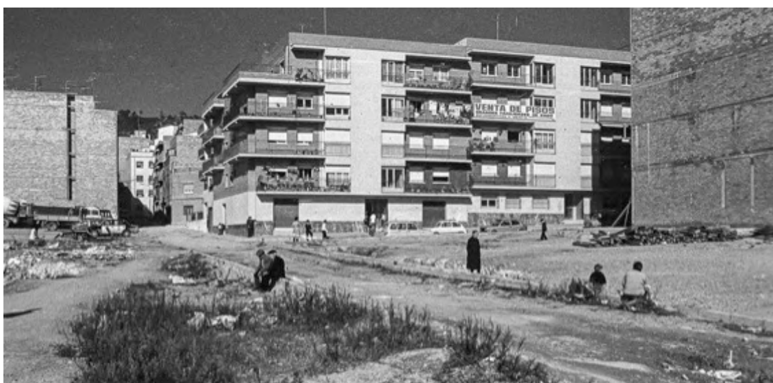
Fig. 01. Viladecans (1980). Calle sin urbanizar. Fuente: Google.
