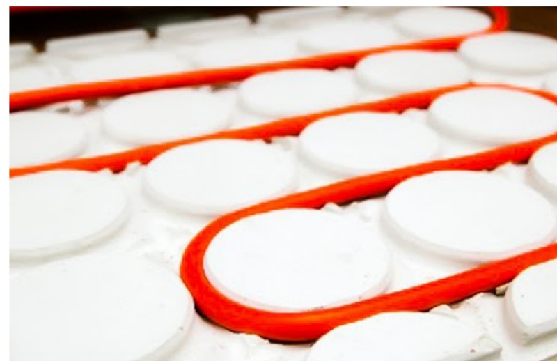
Ciucuit elèctric: Els cables d'electricitat es col·loquen segons conveniència entre els espais buits de la placa.
