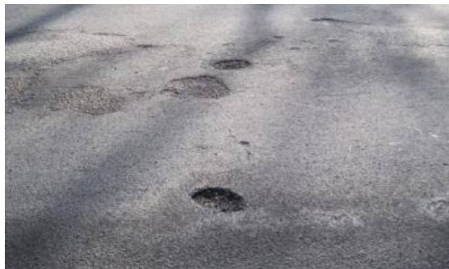
Il·lustració 2.1 - Efectes del stripping.
