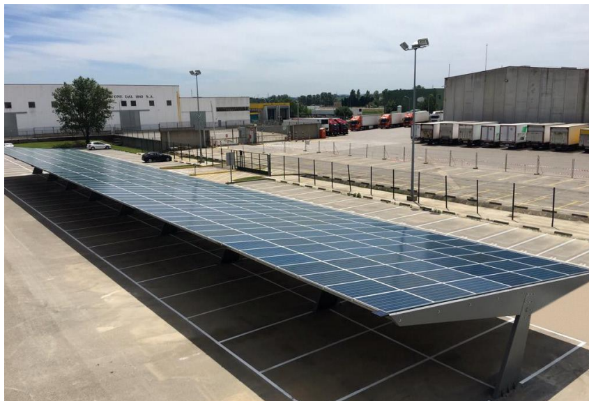
Imatge 8 Marquesina de Innova Green Energy.
