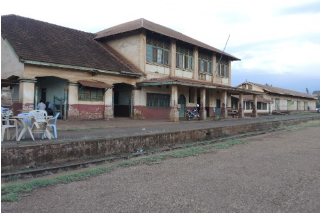
Figura. 03 Edificio principal de la estación de tren. Moshi. Fuente: (García, 2017)
