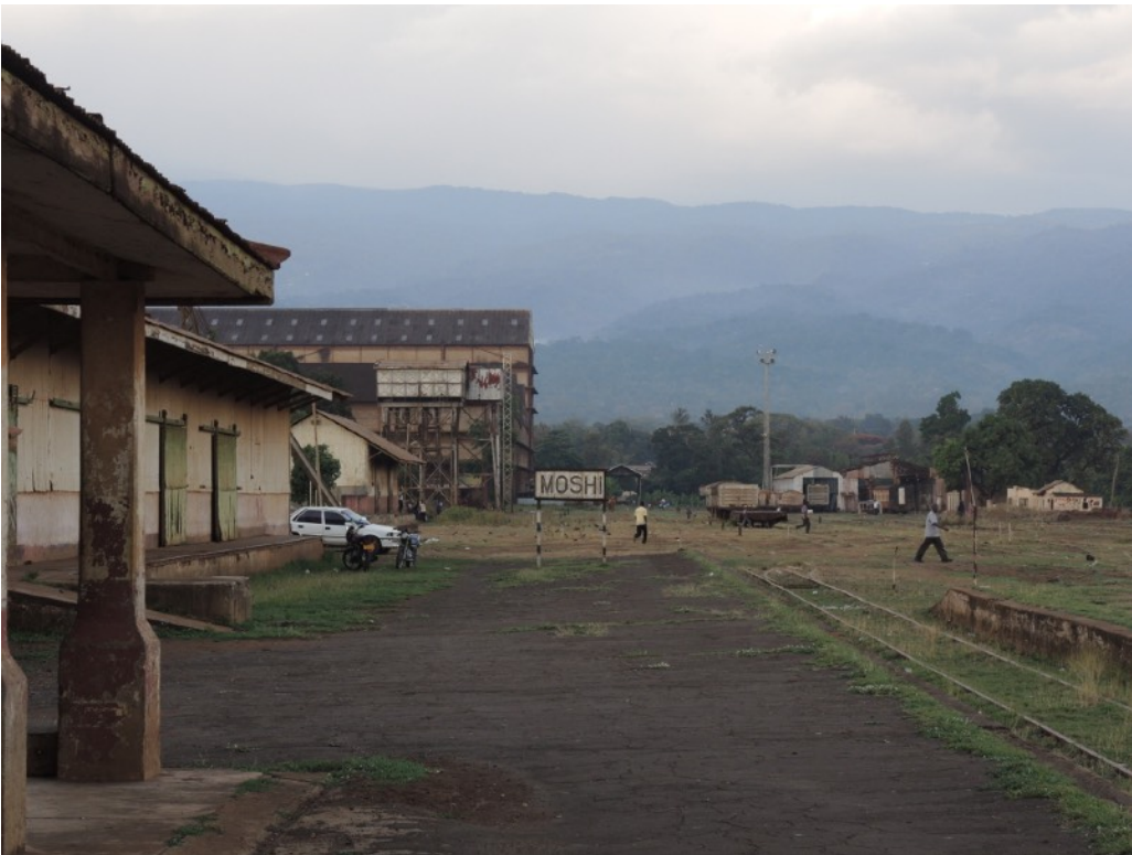
Figura. 02 La abandonada estación de tren de Moshi, hoy inactiva. Fuente: (Malesani, 2017)
