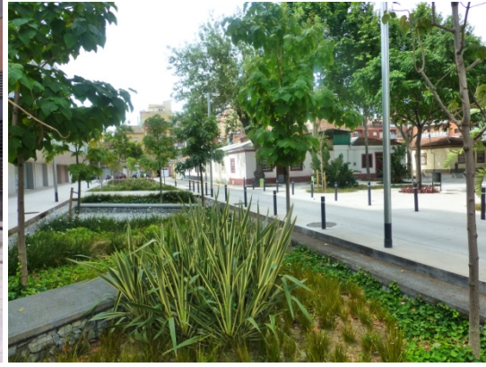
Figura 4.0. Bon Pastor, Calle Biosca. Franja de biorretención.
