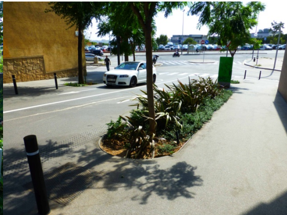
Figura 5.1. Pl. de les dones de Nou Barris. Área de biorretención.
