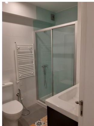
Figura 121 - Final de obra - I.S. Fonte: autor
