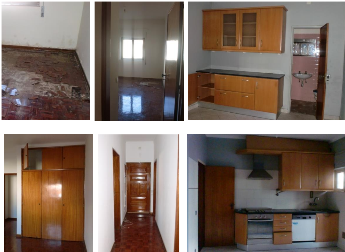
Figura 70 - Fotografias estado atual. Fonte: Biblioteca atelier
