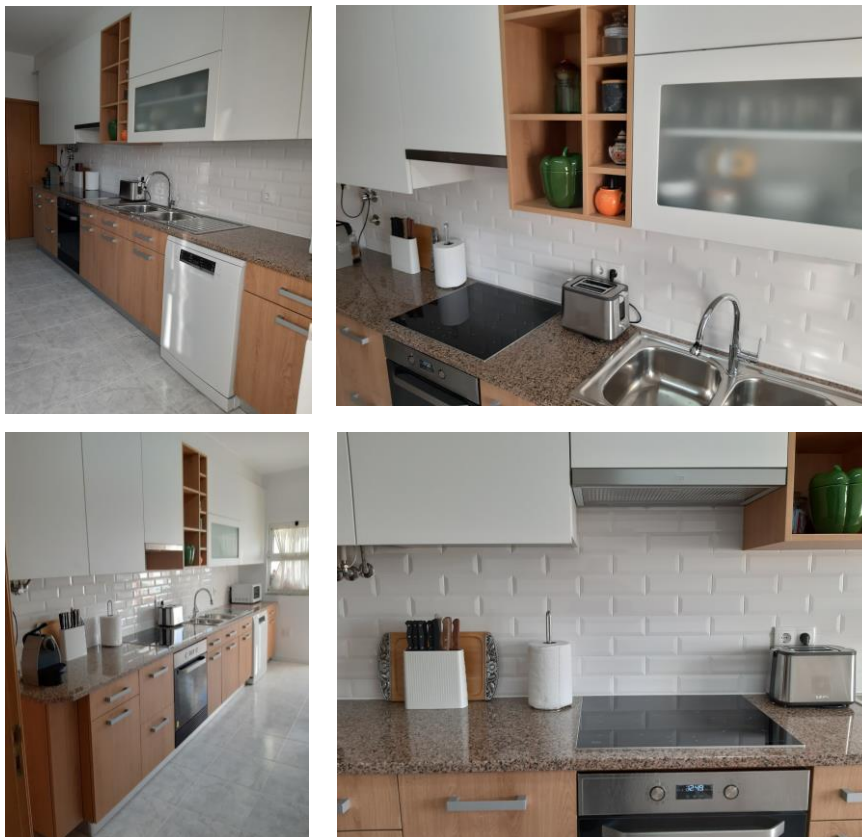
Figura 197 -Fotografia após remodelação. Fonte: autor
