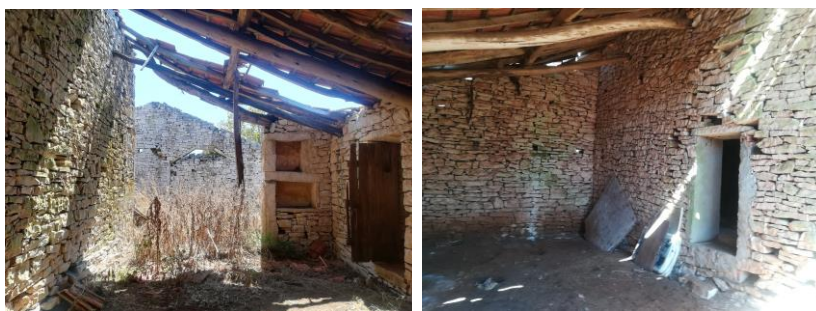
Figura 59 - Fotografias do estado atual - futuro quarto e pátio interior. Fonte: Biblioteca atelier
