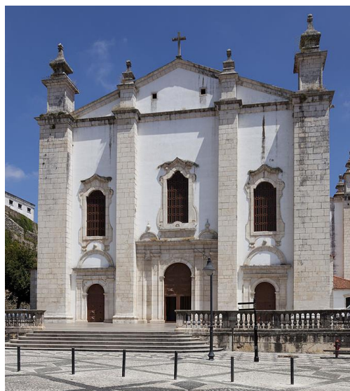
Figura 25 - Fachada Sé de Leiria. Fonte: autor
