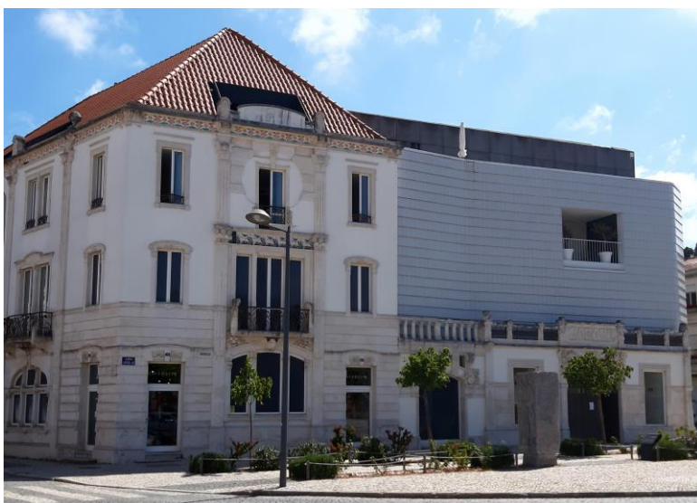
Figura 24 - Edifício Garage. Fonte: autor
