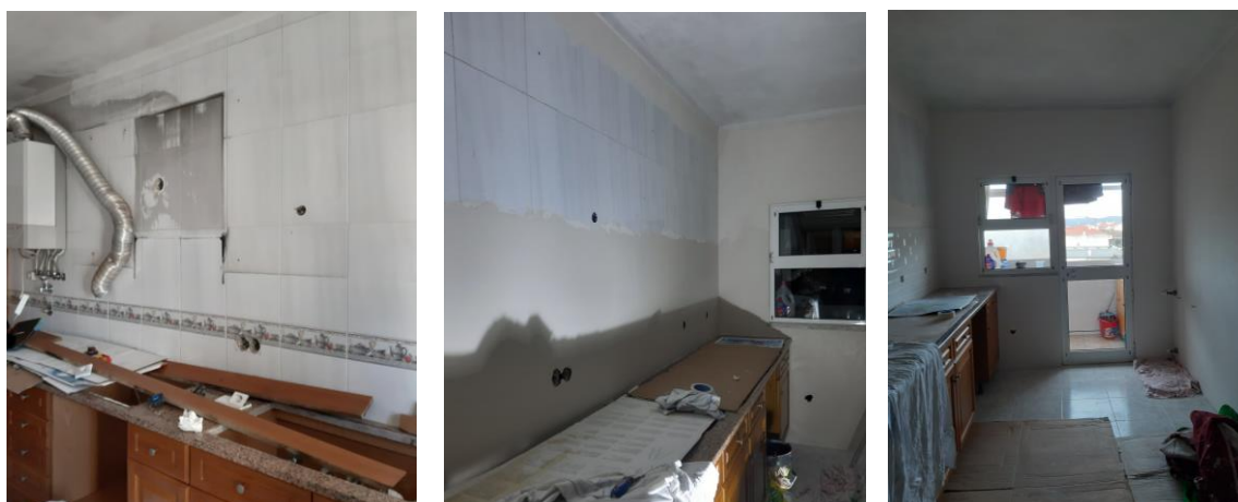
Figura 195 - Progresso do desenvolvimento de obra. Fonte: autor
