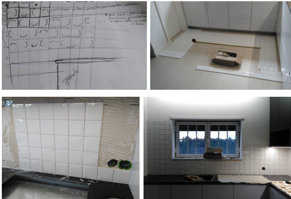
Figura 160 - Esquema para colocação de revestimento cerâmico na cozinha e fotografias do desenvolvimento em obra. Fonte: autor
