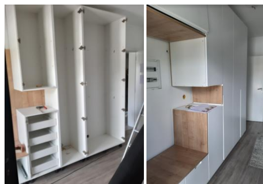
Figura 186 - Montagem do armário no local. Fonte: autor
