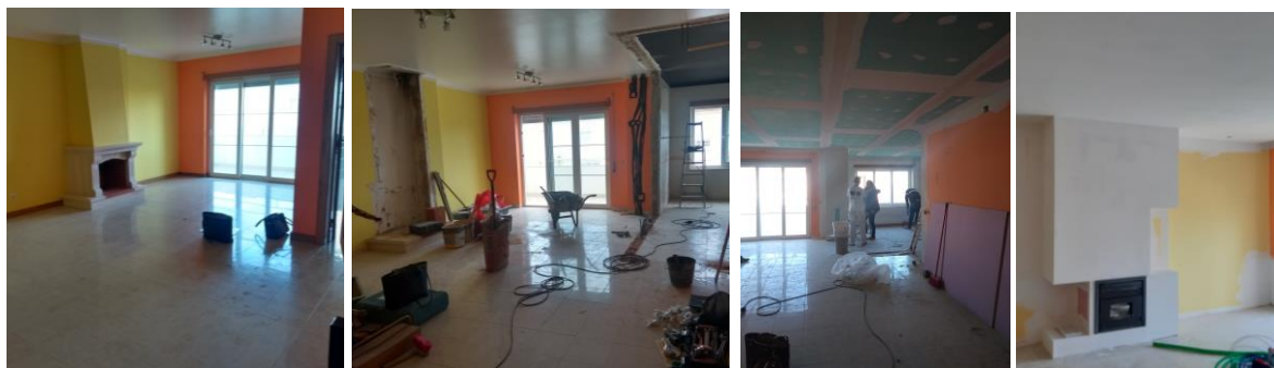
Figura 116 - Início de obra - Sala e Cozinha. Fonte: Biblioteca atelier
