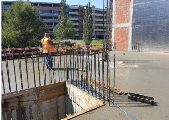
Figura 3.95 - Cura da laje através de rega da superfície
