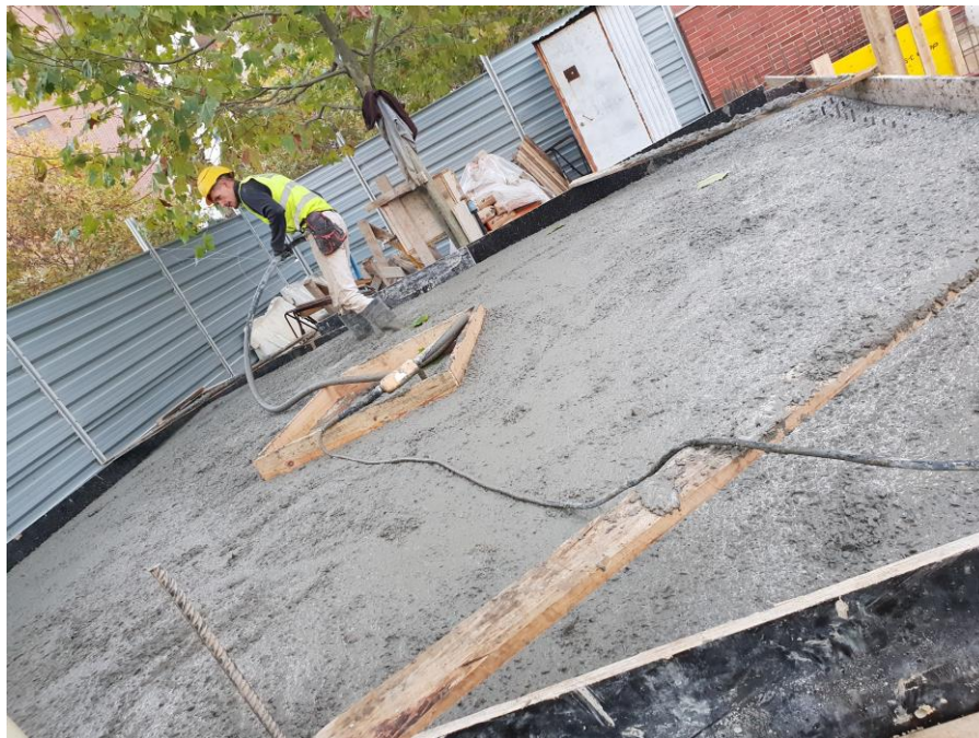
Figura 3.6 - Execução da sapata para colocação da grua
