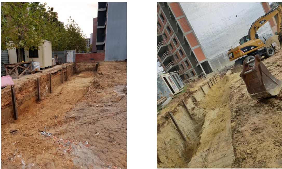
Figura 3.19 - Zona da viga de coroamento escavada
