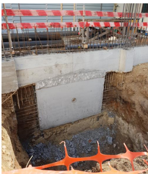
Figura 3.28 - Painel descofrado
