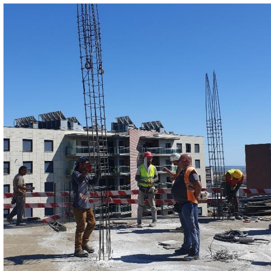
Figura 3.82 - Colocação da armadura do pilar
