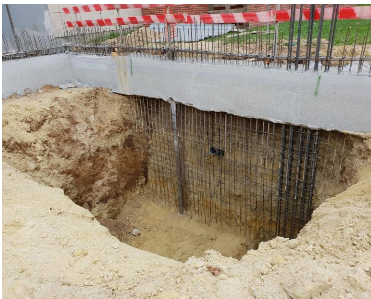
Figura 3.24 - Armadura para painel primário que inclui armaduras de espera
