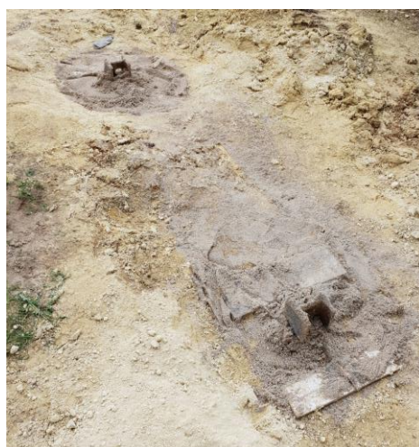
Figura 3.17 - Furo preenchido com areia
