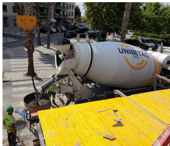
Figura 3.87 - Enchimento do balde
