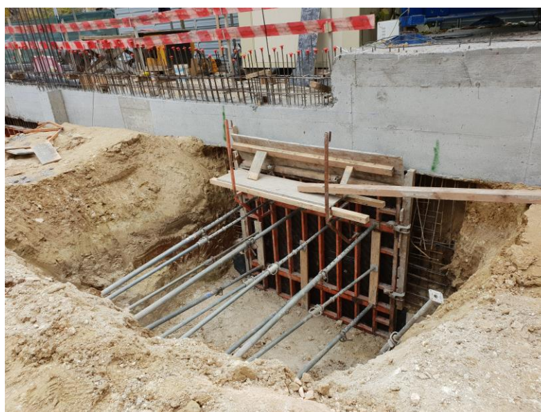
Figura 3.26 - Cofragem de painel primário
