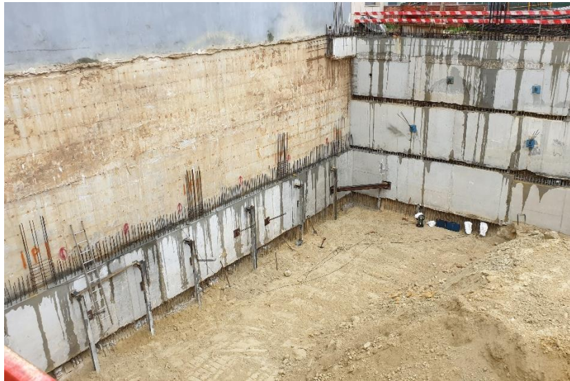
Figura 3.43 - Perfis metálicos após a construção da parede de contenção lateral
