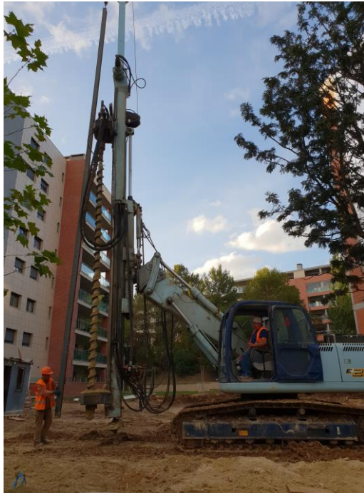
Figura 3.16 - Içamento e introdução do perfil no furo
