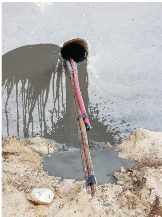
Figura 3.33 - Aspeto do furo após a selagem do bolbo
