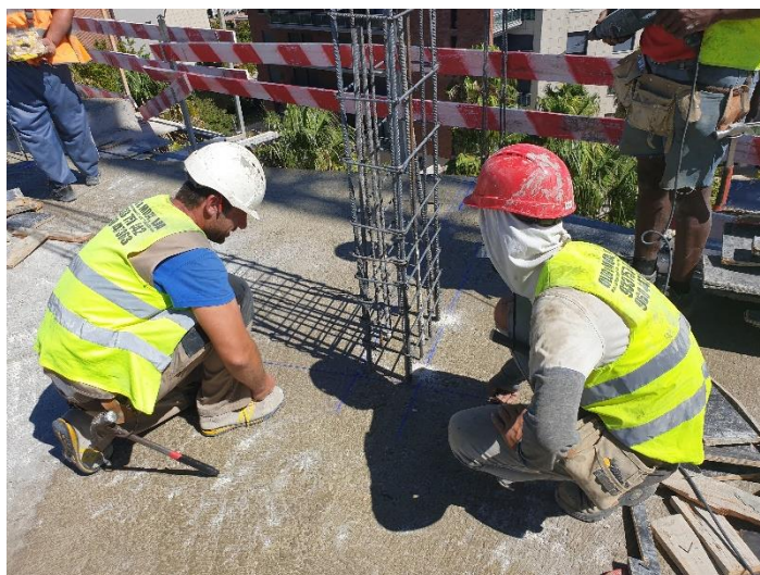
Figura 3.83 - Marcação dos pilares
