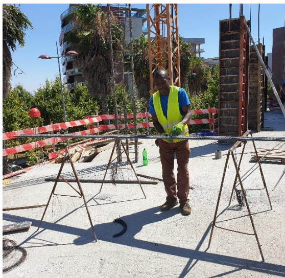
Figura 3.81 - Marcação da posição das cintas
