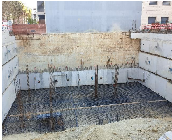
Figura 3.72 - Primeira fase do ensoleiramento geral
