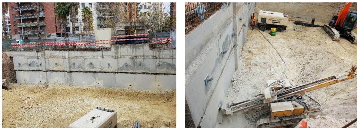
Figura 3.49 - Ancoragens do segundo nível
