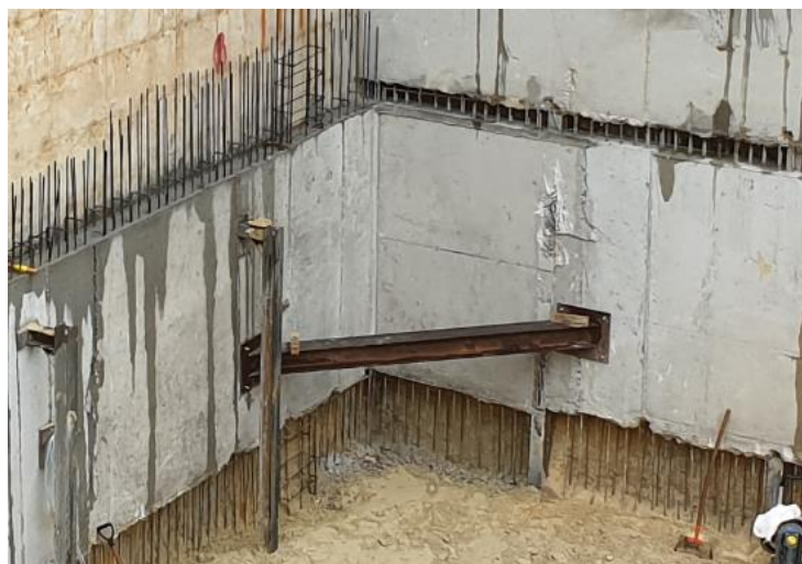
Figura 3.44 - Escoramento dos painéis terciários
