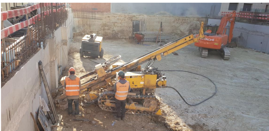
Figura 3.30 - Máquina de furação
