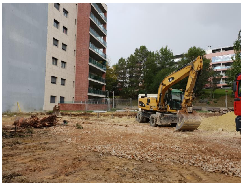
Figura 3.4 - Terreno após a decapagem
