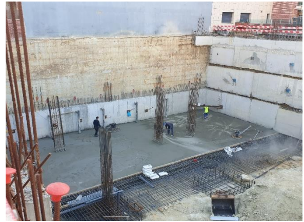
Figura 3.71 - Espalhamento da argamassa em pó e afagamento do piso
