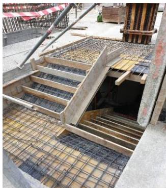
Figura 3.98 - Colocação de moldes nos degraus
