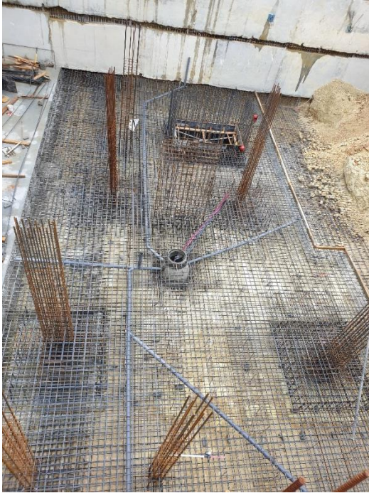
Figura 3.73 - Segunda fase do ensoleiramento geral
