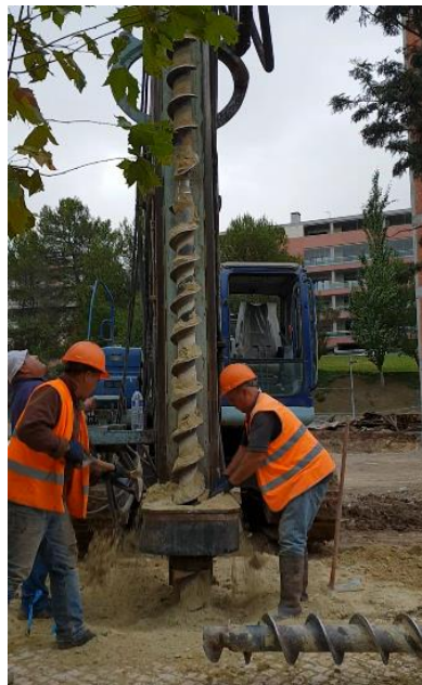
Figura 3.15 - Execução de furo para colocação do perfil
