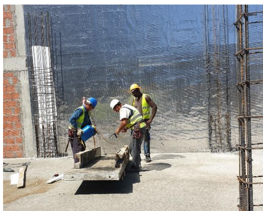
Figura 3.84 - Aplicação de óleo descofrante
