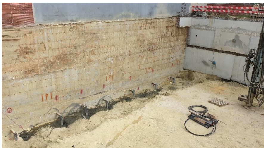
Figura 3.42 - Perfis metálicos na lateral do lote
