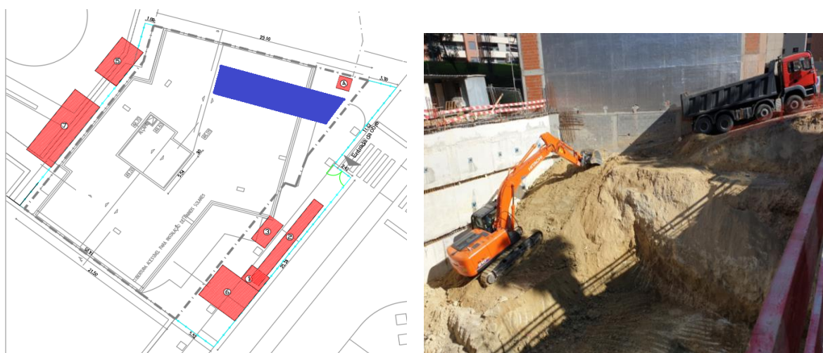
Figura 3.9 - Percurso efetuado pelos camiões na fase intermédia de remoção de terras
