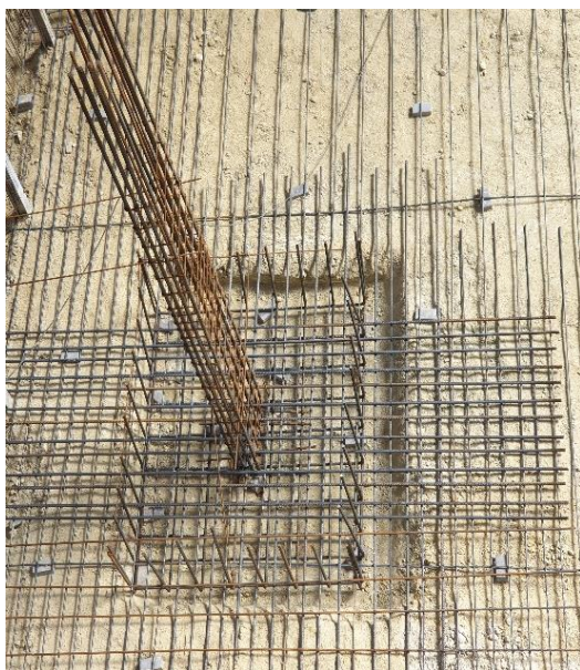
Figura 3.62 - Armaduras de arranque de um pilar
