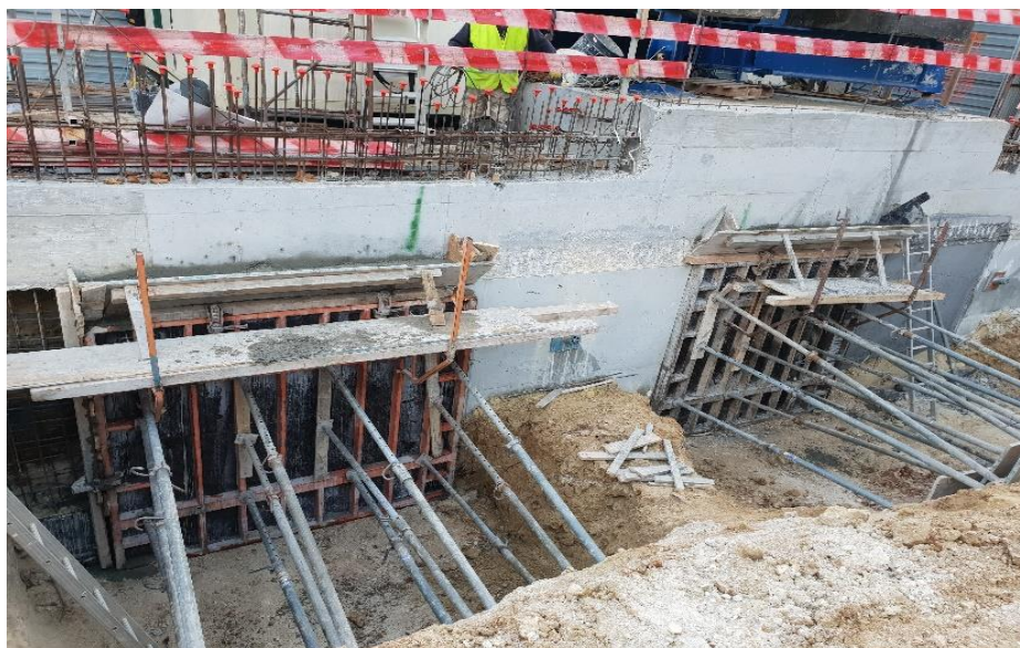
Figura 3.37 – Betonagem de painéis secundários
