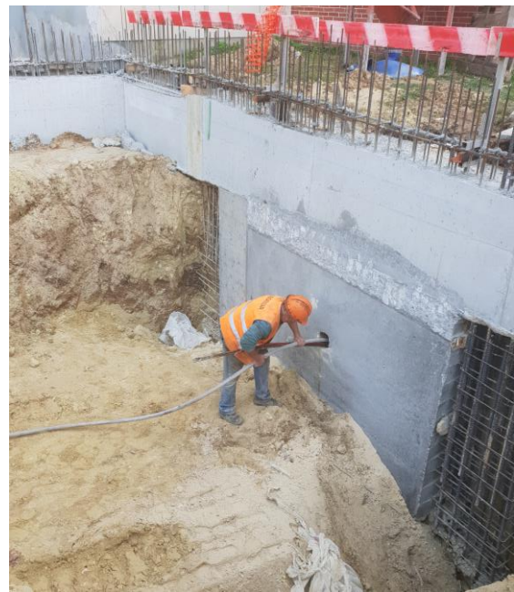
Figura 3.32 - Selagem da armadura
