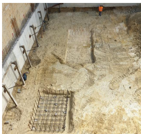
Figura 3.61 - Escavação para colocação dos capitéis dos pilares
