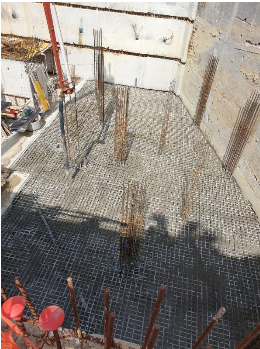
Figura 3.74 - Terceira fase do ensoleiramento geral
