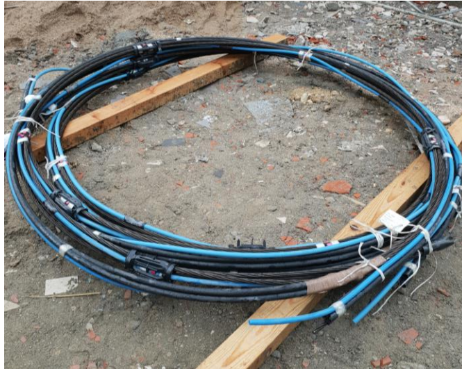
Figura 3.31 - Cabos de ancoragem em rolo
