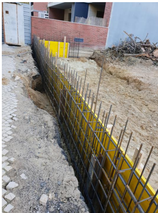
Figura 3.21 - Cofragem da viga de coroamento
