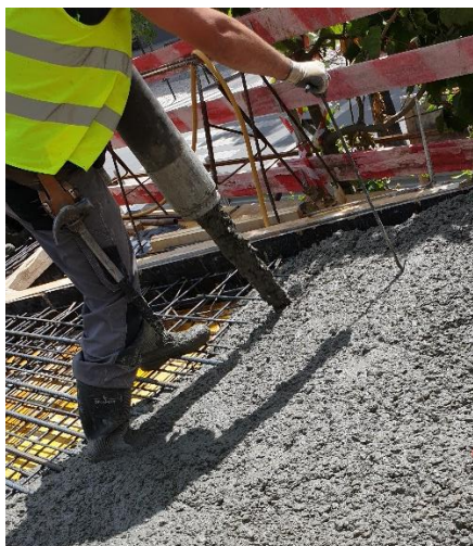
Figura 3.93 - Bitola de aço para controlo da espessura da laje
