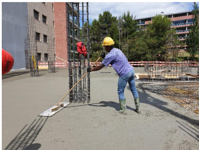
Figura 3.94 - Alisamento da superfície da laje
