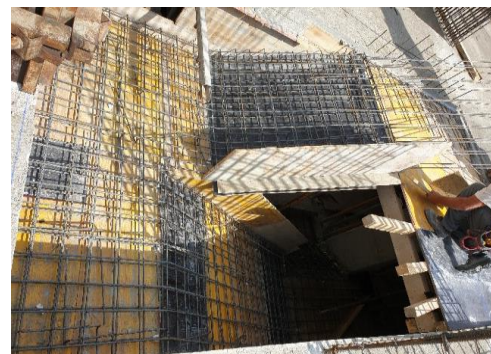
Figura 3.97 - Colocação das armaduras
