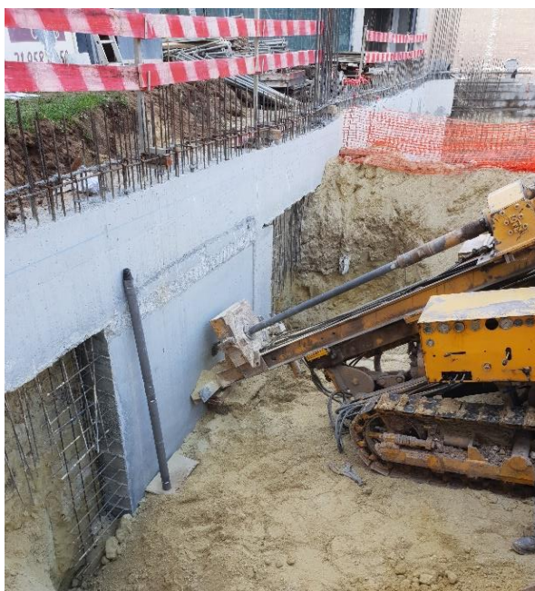
Figura 3.46 - Ancoragens nos painéis primários do 1º nível
