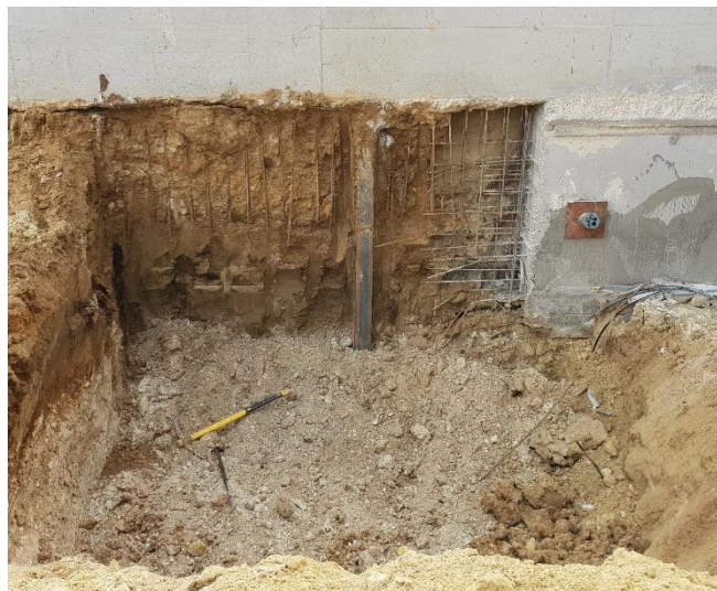
Figura 3.36 - Escavação de painel secundário
