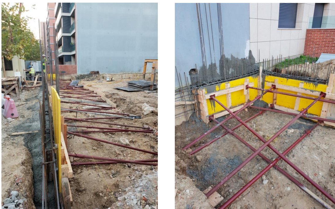
Figura 3.22 - Betonagem da viga de coroamento
