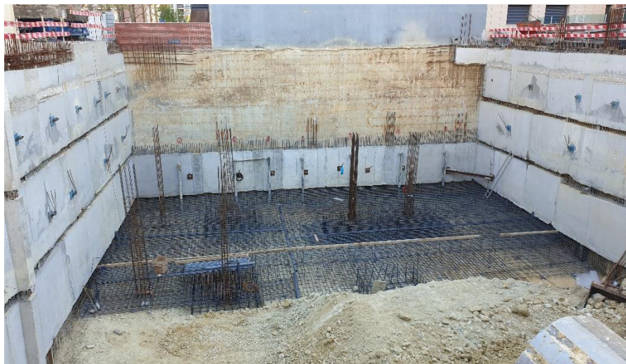
Figura 3.40 - Contenção periférica concluída
