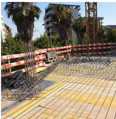
Figura 3.91 - Viga de bordadura
