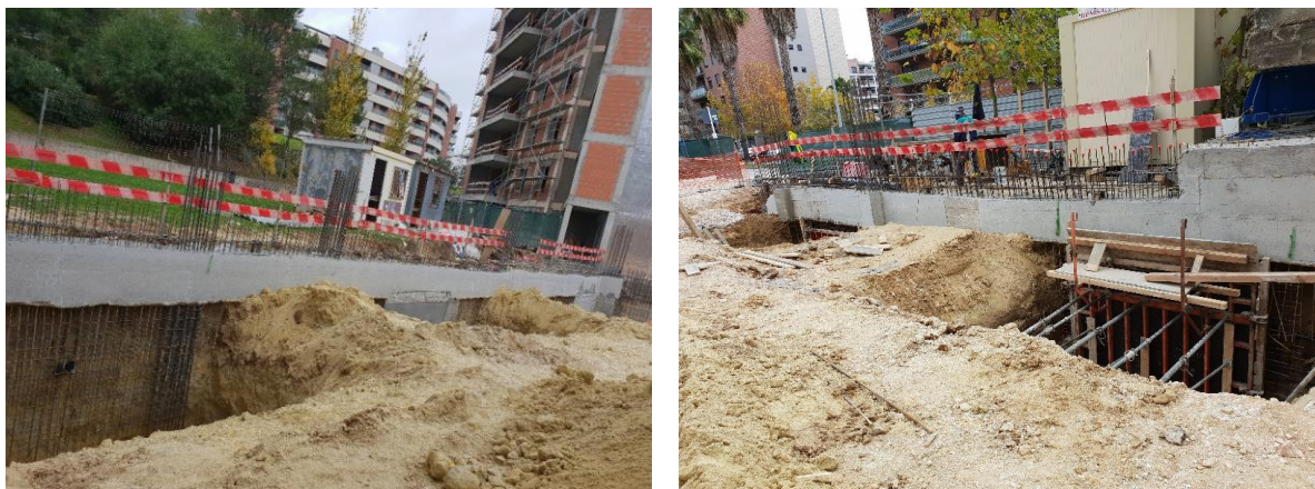
Figura 3.45 - Abertura dos painéis primários do 1º nível
