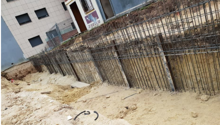
Figura 3.20 - Armadura da viga de coroamento
