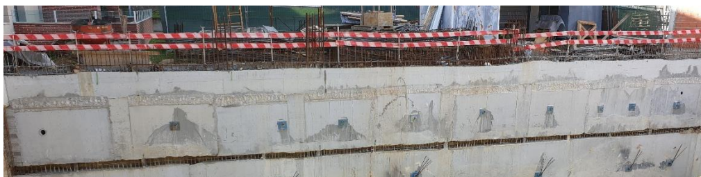
Figura 3.38 - Primeiro nível da parede de contenção com ancoragens
