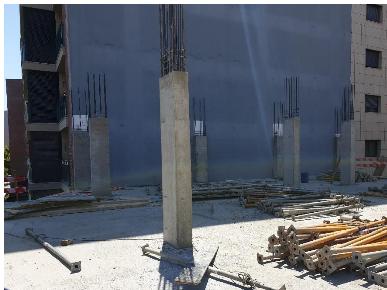
Figura 3.88 - Pilares descofrados
