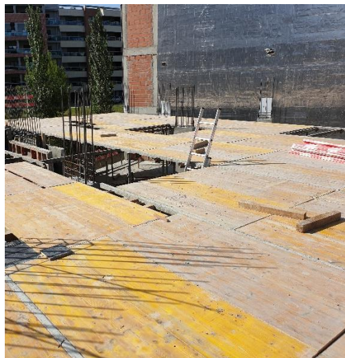
Figura 3.90 - Painéis de madeira tricapa
