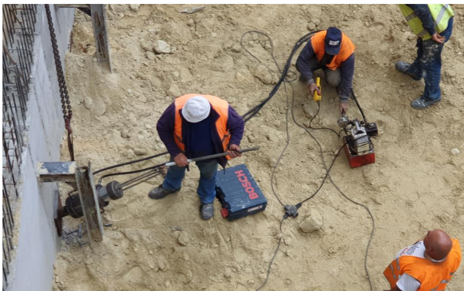
Figura 3.34 - Aplicação do pré-esforço
