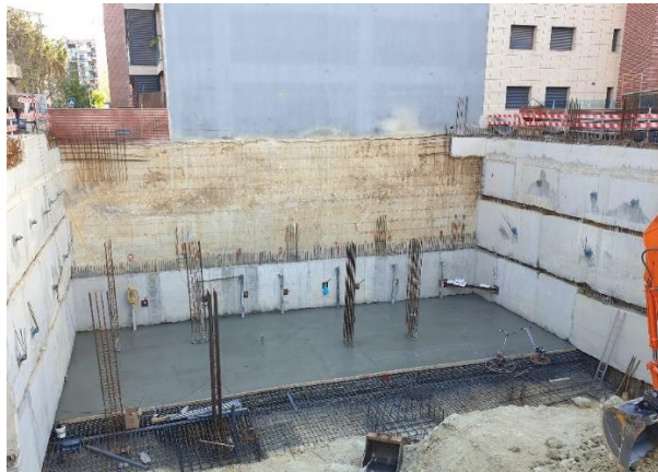
Figura 3.70 - Cura do betão
