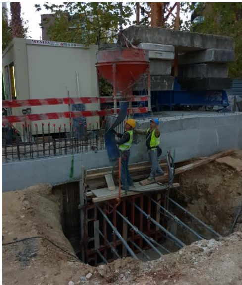
Figura 3.27 - Betonagem de painel primário
