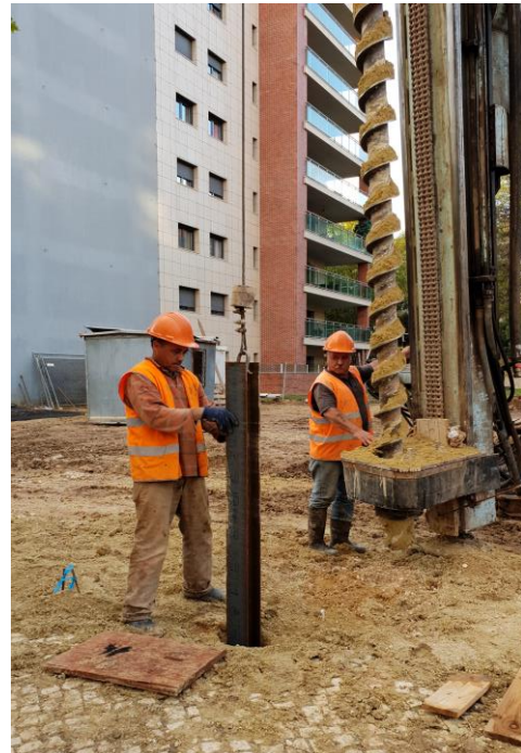
Figura 3.16 - Içamento e introdução do perfil no furo
