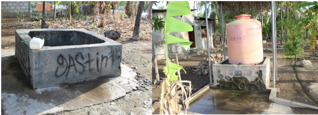
Figura 40: Poço de água e tranque de água potável na comunidade do Suco Biqueli
