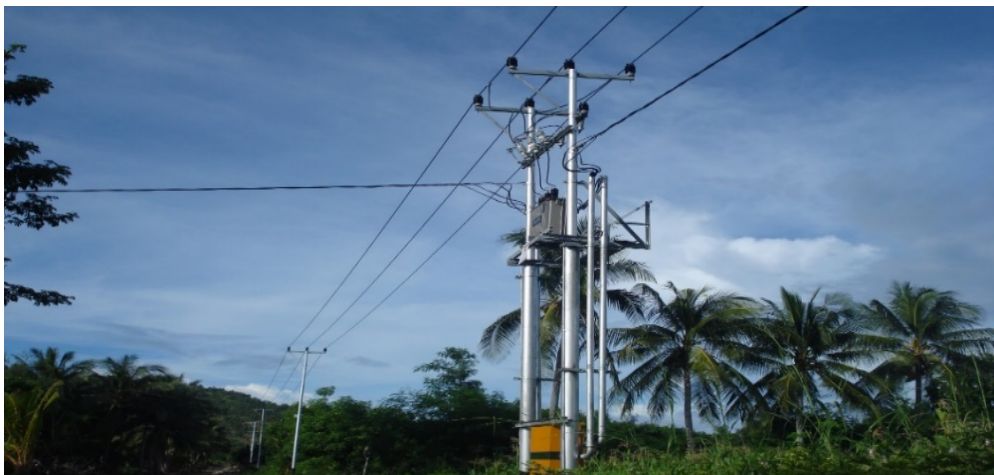
Figura 38: A instalação a energia da eletricidade na comunidade do Suco Biqueli em 2011 depois de 11 anos de Restauração da Independência 20 de Maio de 2002
