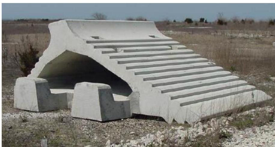
Fig. 2.9 - Beachsaver Reef e pormenor do mecanismo de ligação entre módulos (US Army, 2002).
