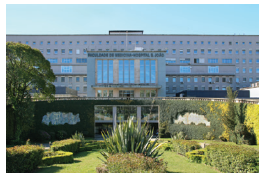
Figure 1 Centro Hospitalar de São João, Porto, Portugal.
