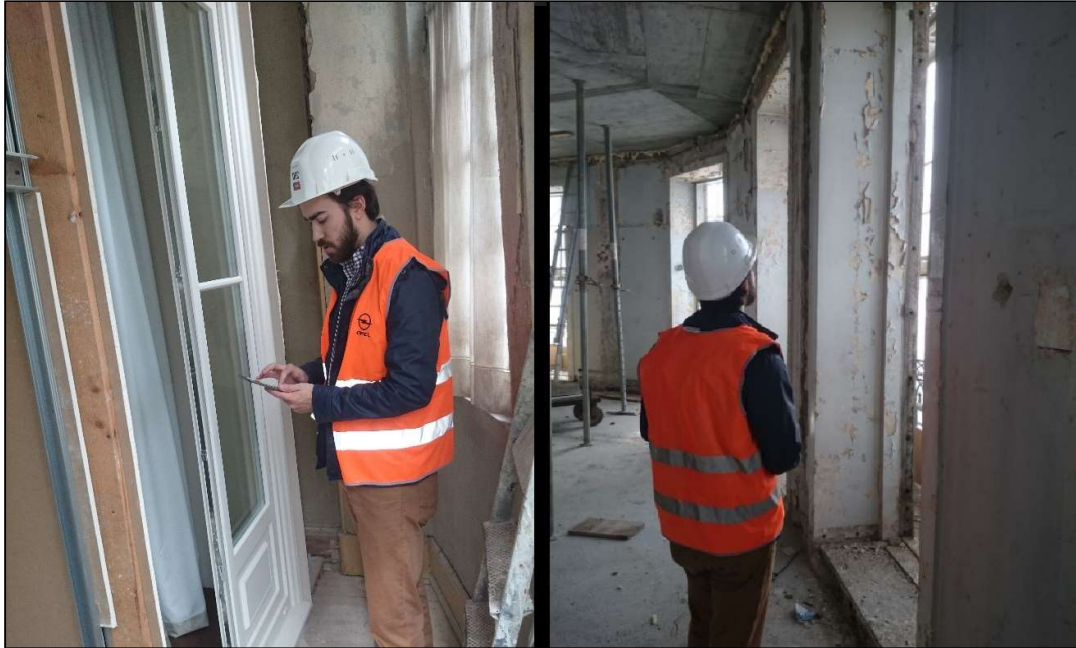
Fig.5.15 – Ilustração do vão em análise no quarto modelo (à esquerda) e a sua localização na obra (à direita)
