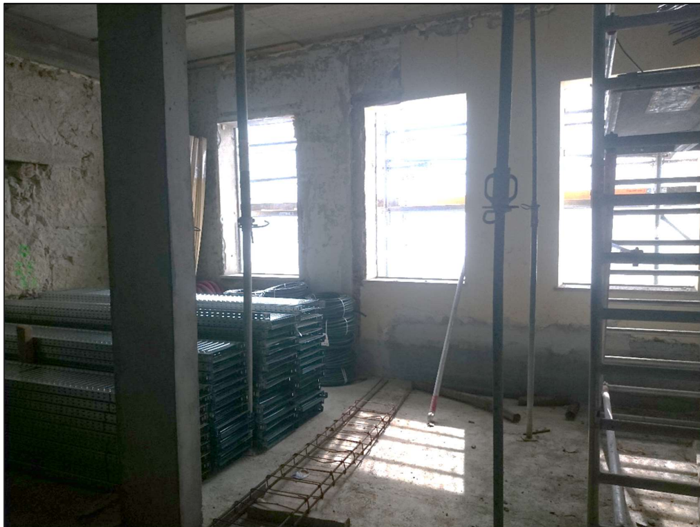
Vãos “JE” do edifício (piso 1)
