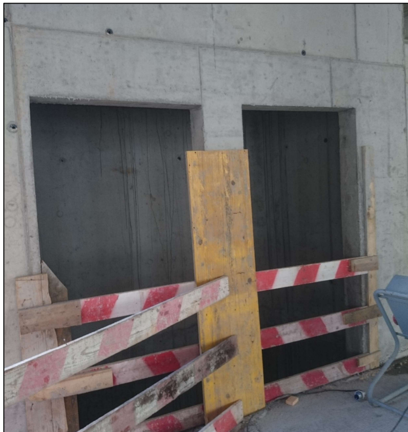
Caixa de elevadores do edifício
