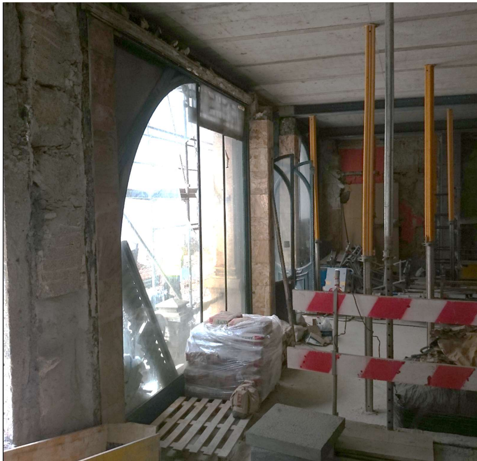
Vão “SR6” do edifício (piso 0)
