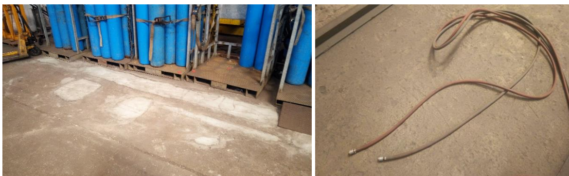
Figura 31 – Buracos tapados e mangueiras novas
