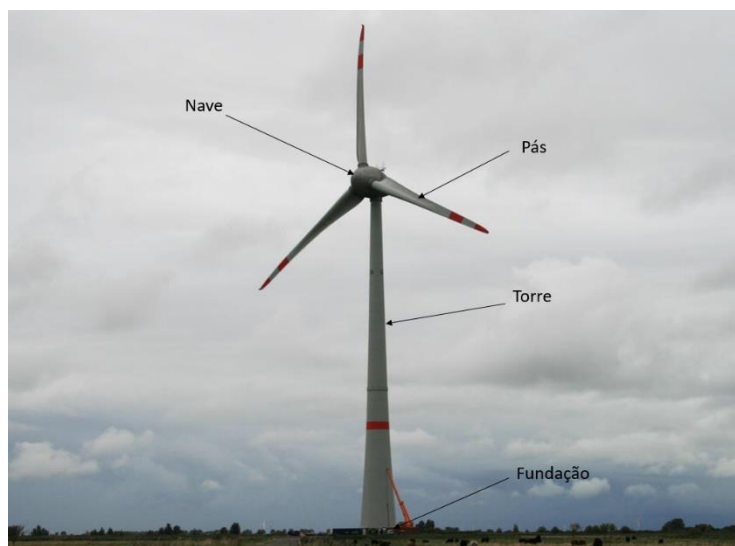
Figura 10 – Estrutura de uma torre eólica (Prandi 2012)
