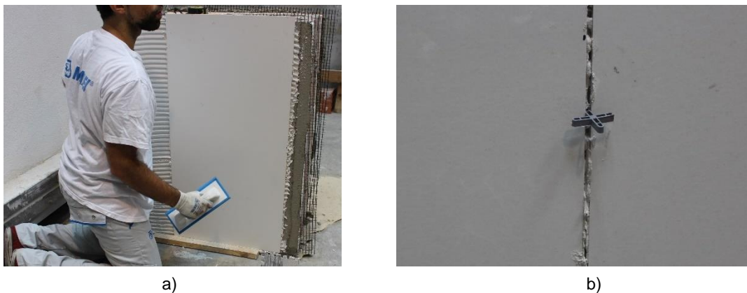
Figura 22 – a) Aplicação do cerâmico na Face A; b) Espaçadores de 5 mm
