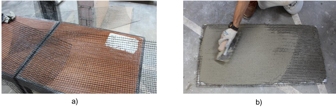
Figura 18 – a) Rede de fibra de vidro; b) Aplicação da rede de fibra de vidro
