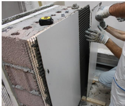
Figura 24 – Aplicação do cerâmico na Face B
