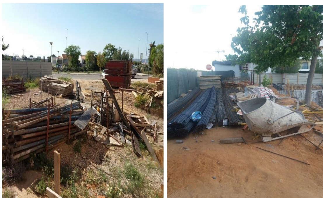
Fig. 6.4. – Pequenos estaleiros - área de armazenamento: descarga, cofragem, aço.
