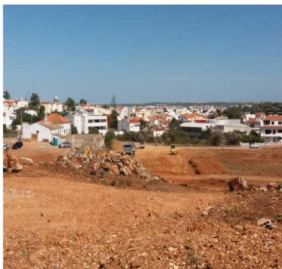
Fig. 7.4. – Operação de Terraplanagem
