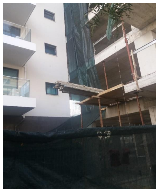
Fig.5.4.b) – Construção de edifício contíguo
