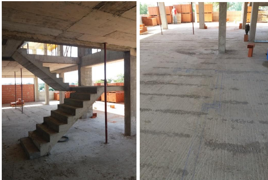
Fig. 6.5.c) – Exemplo: Início da tarefa de colocação de alvenaria
