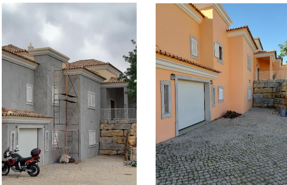
Fig. 2.4.e) – Tratamento de fissuração e pintura
