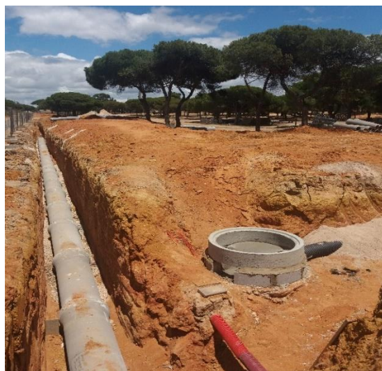
Fig. 8.4. – Operação de Loteamento-instalação de redes
