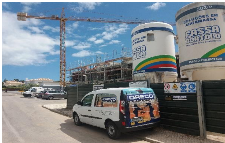
Fig. 2.3.a) – Exemplo de construção de complexo habitacional – empreiteiro de Matosinhos
