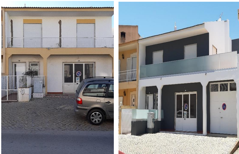
Fig. 2.4.d) – Remodelação de Fachada
