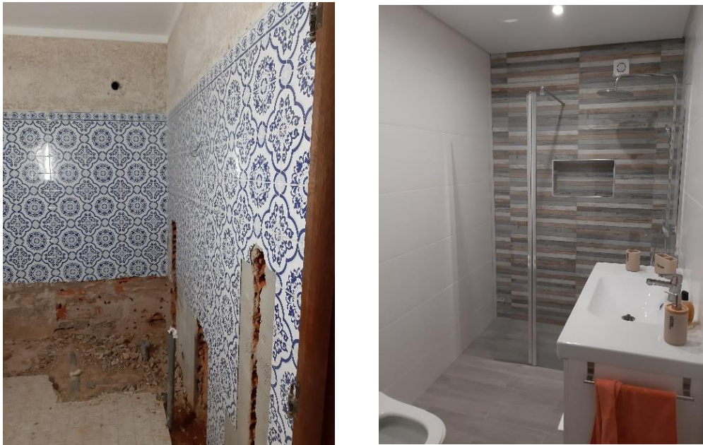
Fig. 2.4.b) – Remodelação de casa de banho
