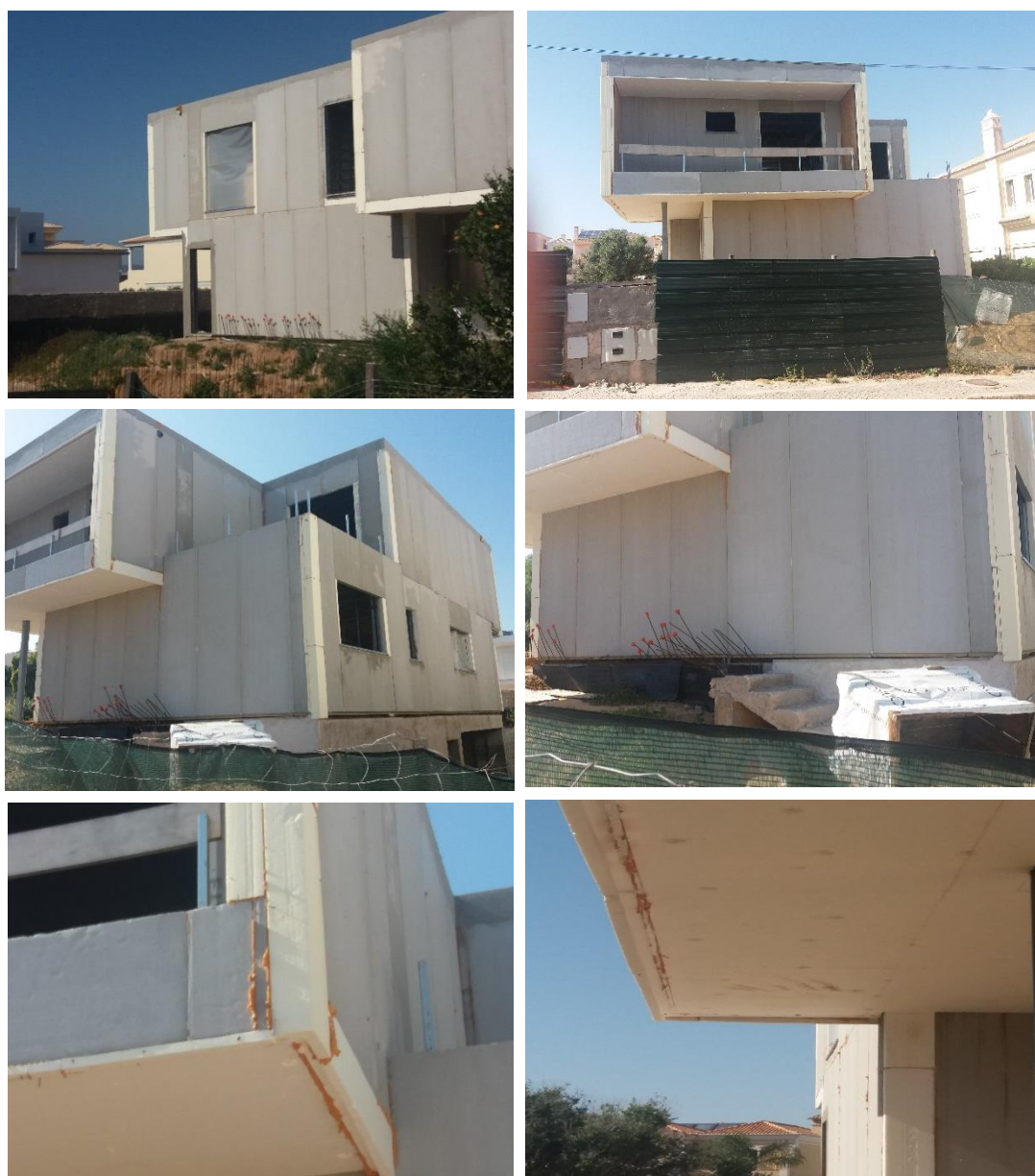
Fig. 1.4. - Moradia com estrutura de aço e betão pré-fabricado – cidade de Faro
