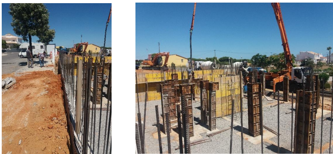
Fig. 3.4.b) – Construção de edifício multifamiliar: subempreiteiros da escavação e estrutura de betão armado – gerentes ucranianos (obra não vedada)
