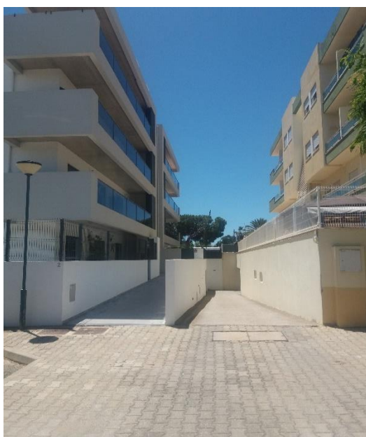
Fig. 5.4.a) – Entrada comum para o piso enterrado (garagem) de um edifício novo (esquerda) com outro já existente (direita) do mesmo loteamento, geradora de conflitos durante a fase de construção.
