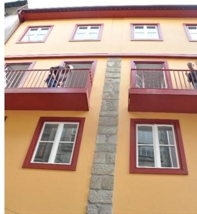
Figura 29 - Fachada em tabique e parede meeira à vista (Porto Vivo, SRU)
