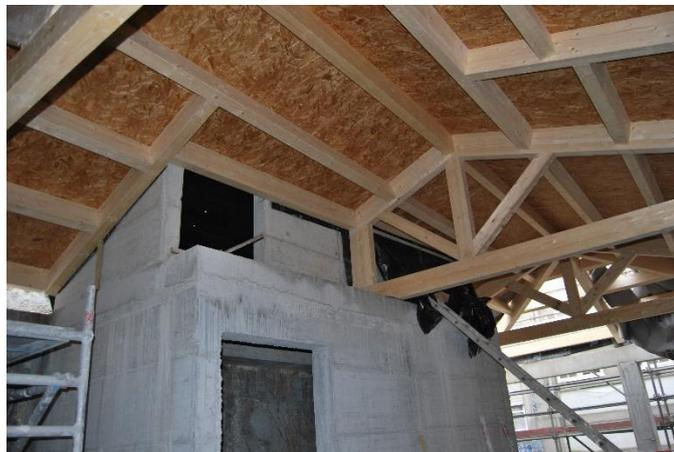
Figura 32 - Execução de cobertura, mantendo a solução original (Porto Vivo, SRU)
