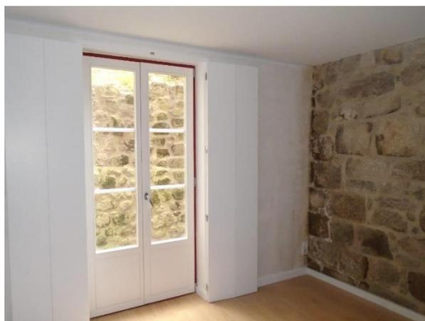
Figura 31 - Parede interior em alvenaria de granito à vista
