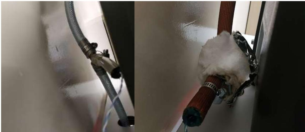
Figura 24- "T" instalado com mangueiras transparentes, à esquerda, e com mangueiras mais reforçadas e com isolamento, à direita.
