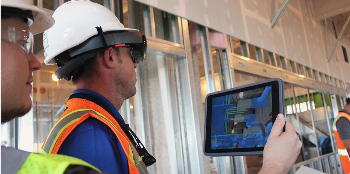
Fig. 2.10 – Utilização de RA na indústria da construção [27]
