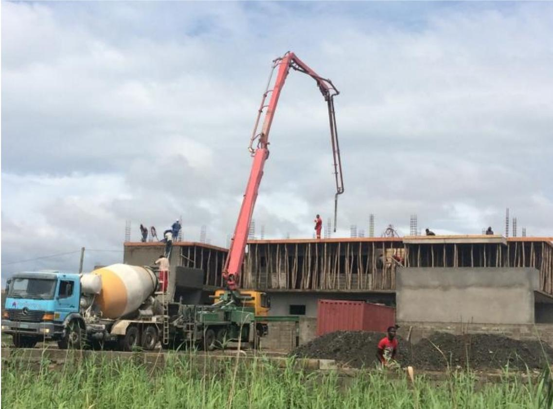
Fig. 5.1 – Betonagem de uma laje [56]
