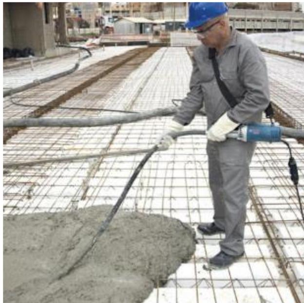
Fig. 5.7 – Correta utilização dos EPI's na execução de uma betonagem [66]
