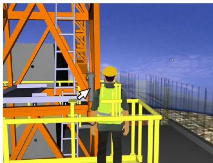
Fig. 3.36 – Desaparafusamento do elemento da grua T1 [36]
