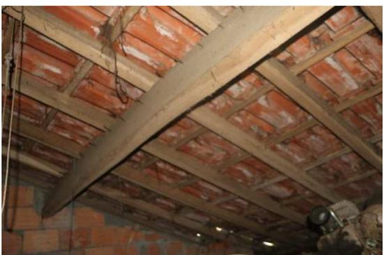
Figura 33: Estrutura do telhado, em madeira de eucalipto.
