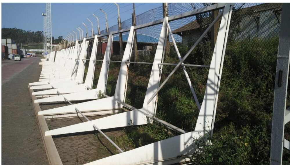
Figura 2.6 - Para-vento sem tela, à espera da colocação final sobre a estrutura de contentores.
