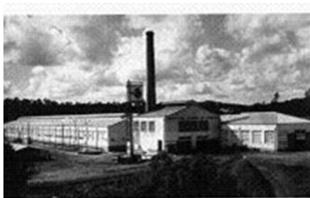
Figura 2.6 - Instalações Iniciais da Mabor[14].
