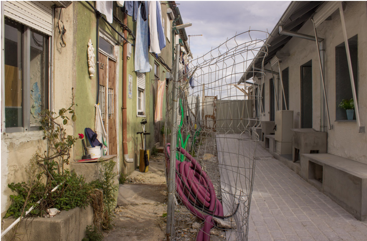
Figura 22: Ilha da Bela Vista durante as obras de reabilitação
