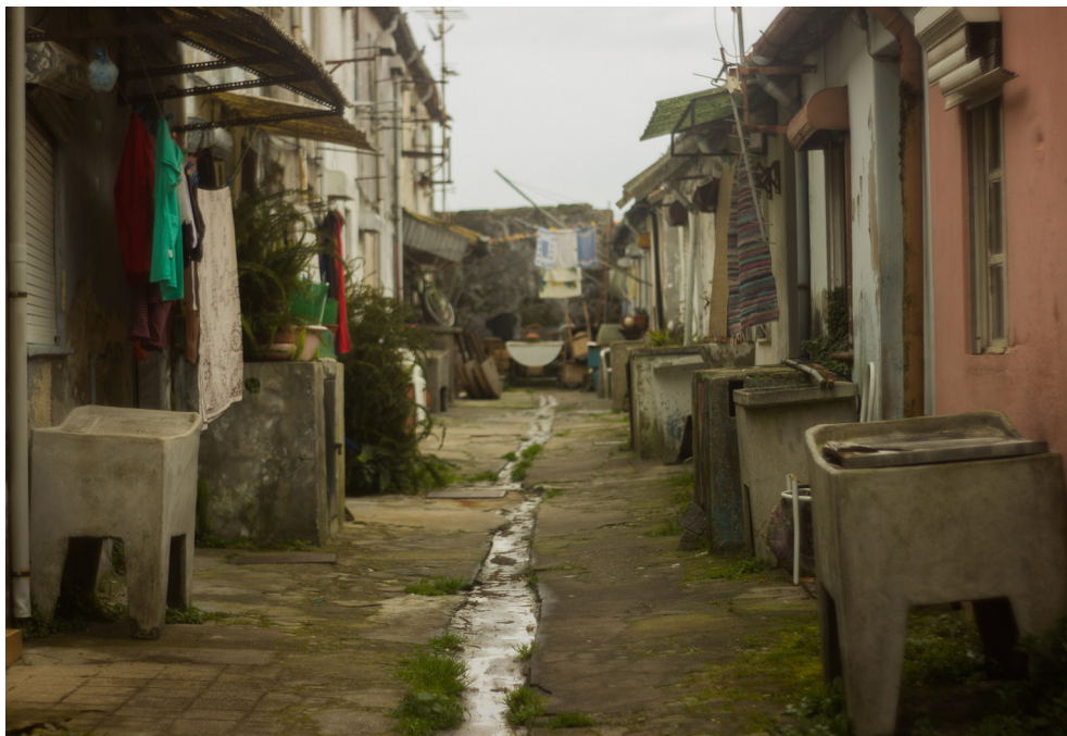
Figura 21: Ilha da Bela Vista, antes das obras, 2014
