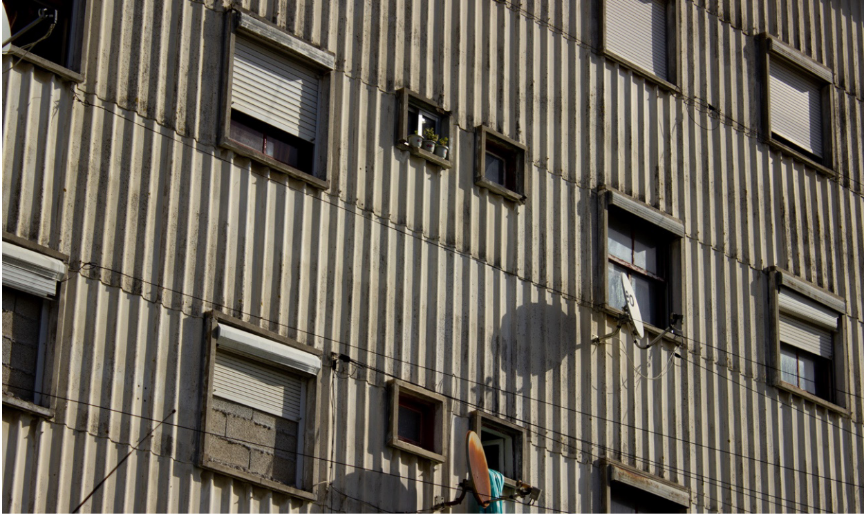
Figura 30: Detalhe de um bloco do bairro Rainha Dona Leonor
