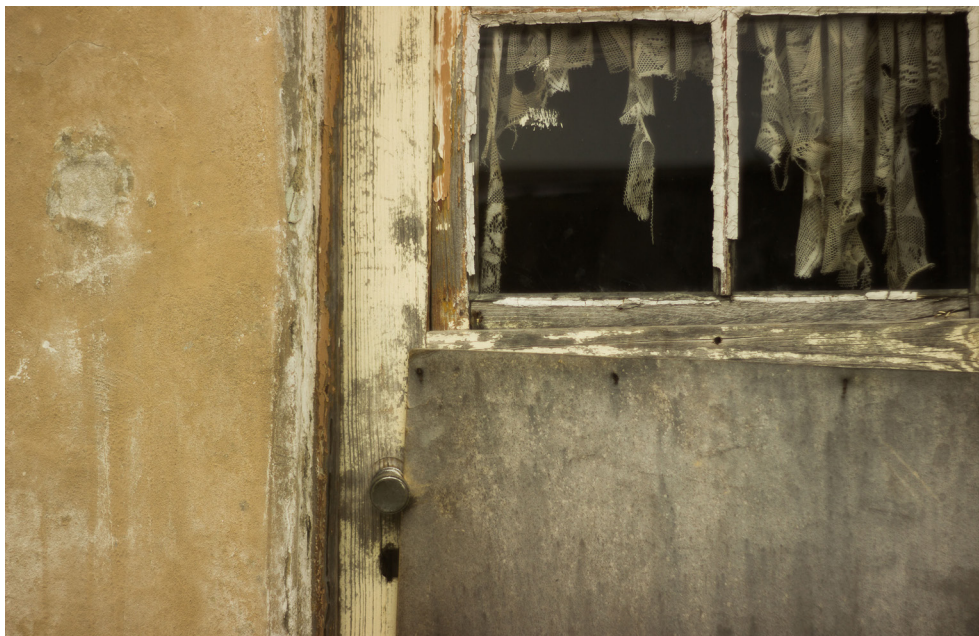
Figura 13: Ilha da Bela Vista, antes das obras
