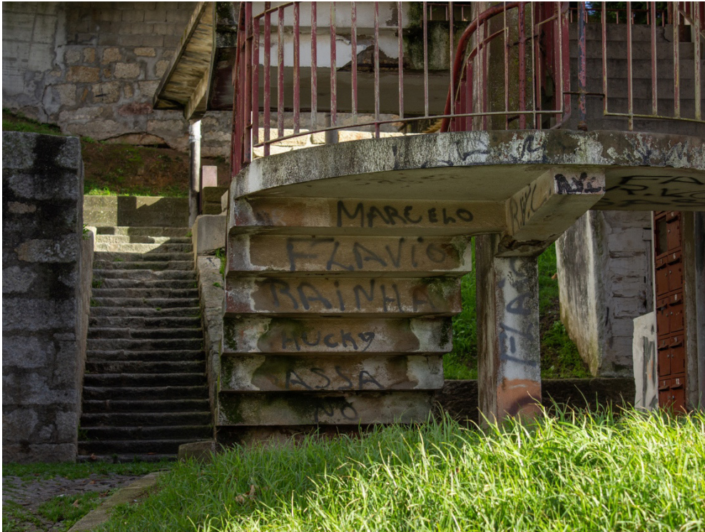
Figura 33: Escadas do antigo bloco do bairro Rainha Dona Leonor.
