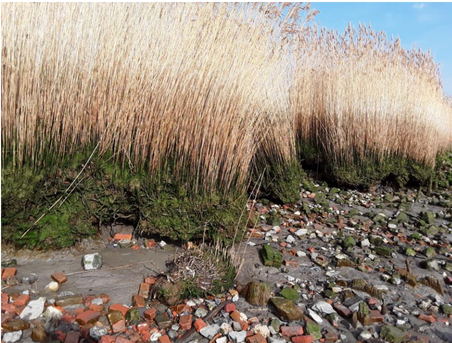
Figuur 30: De riviererosie is plaatselijk eveneens duidelijk aan de hand van de los gespoelde rietwortelkluiten (© Erwin Meylemans 2019, Onroerend Erfgoed).
