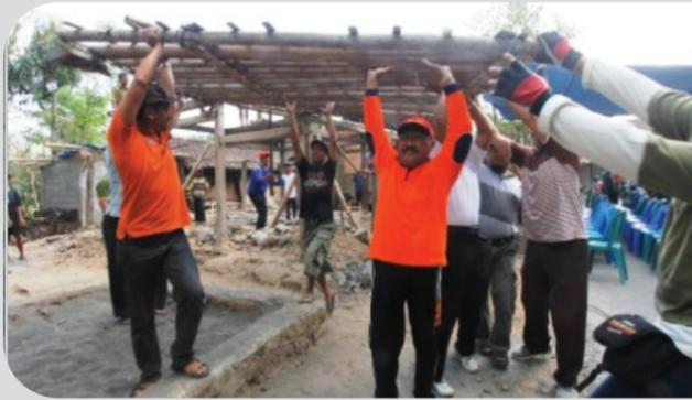
Proses memasang empyak raguman dilakukan secara bersama – sama dengan melibatkan 20 hingga 25 orang. Proses pemasangan dilakukan dengan mengangkat sisi yang paling atas dengan menggunakan tongkat bambu. Pengangkatan ini membutuhkan koordinasi agar dapat bersamaan naik pada sisi atap. Empyak kemudian dipasang menempel pada gording atau jurai rangka atap. Sisi yang menempel kemudian dipaku dengan paku yang terbuat dari kayu (pethek) berukuran panjang 5 cm dan diameter 1.5 – 2 cm.
