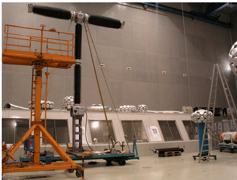
Abbildung 4-7: Strommessungen – Schalter an der Warte
