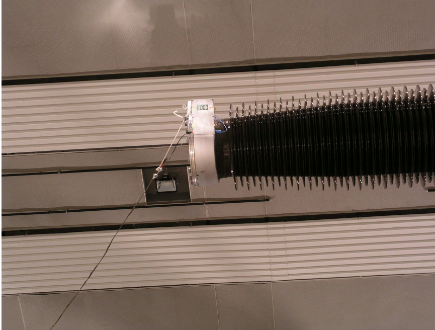
Abbildung 4-5: Multimeter am Leistungsschalter – Strommessung
