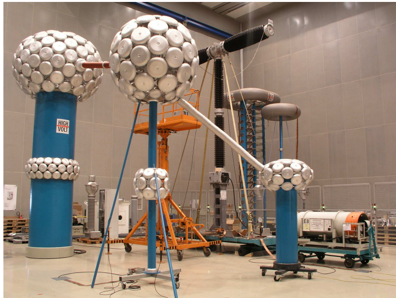
Abbildung 4-6: Strommessungen – Schalter zwischen Stoß- und AC-Anlage
