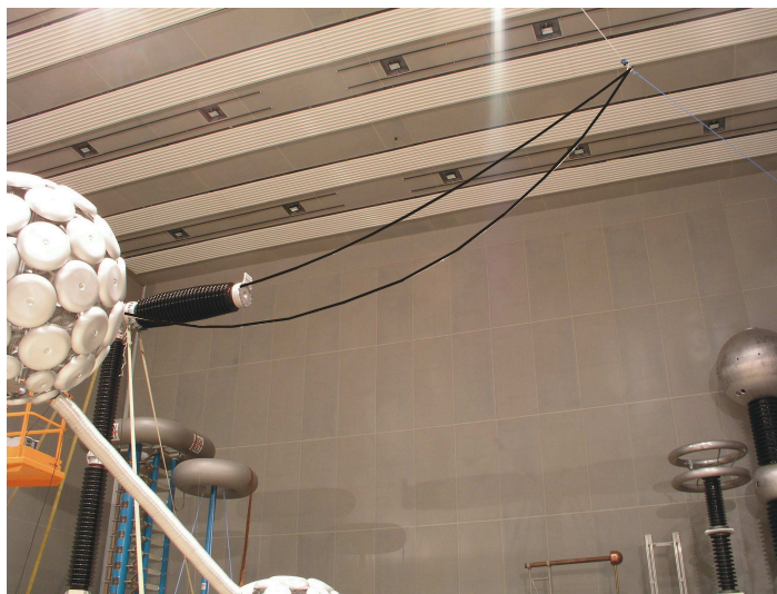
Abbildung 4-22: 1. Brückenmessung: Entfernte Leitungsführung vom Teiler zum Schalter
