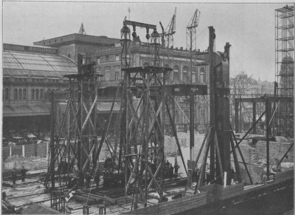
Abbildungen 21 und 22. Montage der großen Rahmenträger über dem Lichtspielsaal. Eisenkonstruktionen des Geschäftshauses Ecke Königgrätzer- und Köthener-Straße in Berlin.
