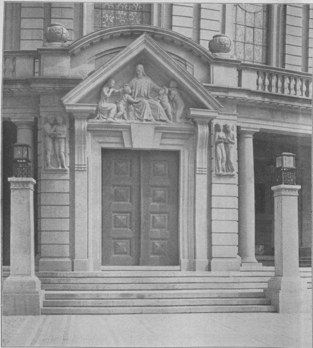
Portal des Haupteinganges.
