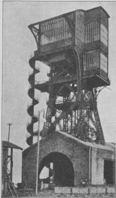
Abbildung 11. Förderturm in Eisen.
