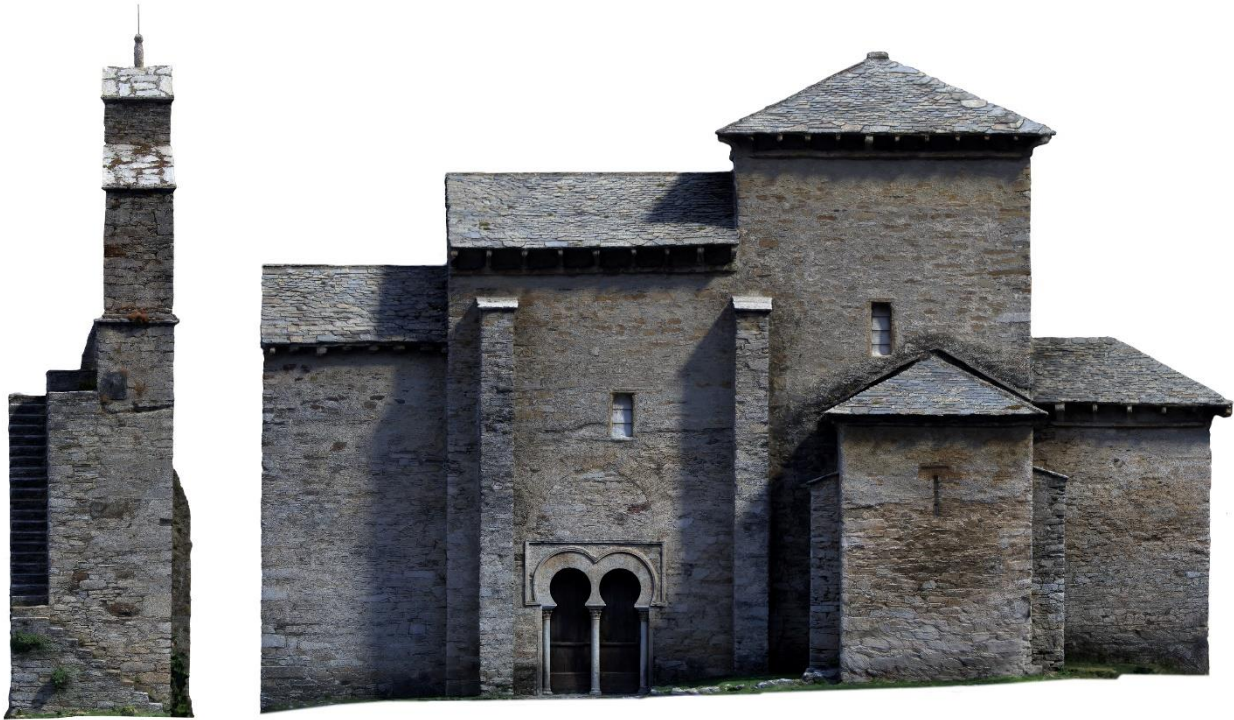
Fig. 4.3. Ortofoto de la fachada meridional de la iglesia de Santiago de Peñalba.
