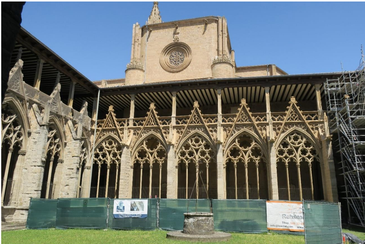
Fig. 4.7. Fachada del claustro durante el proceso de obra.
