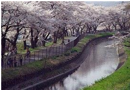
Figura 12. Acueducto de Tamagawa.
