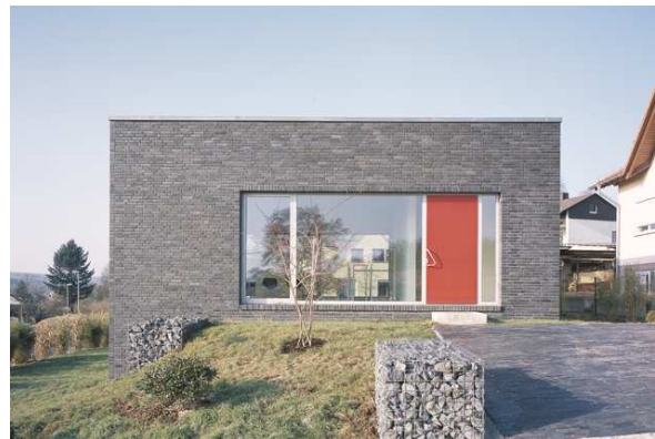
Fig. 3. Fachada de la vivienda.
