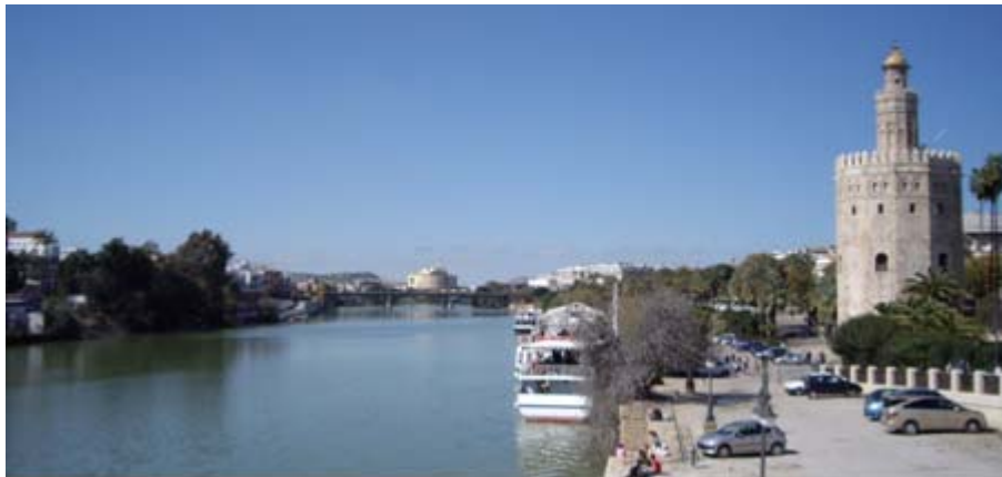
(15) Vista desde el Puente de San Telmo, focalizando el solar de la futura Torre Cajasol, con la Torre del Oro en primer término
