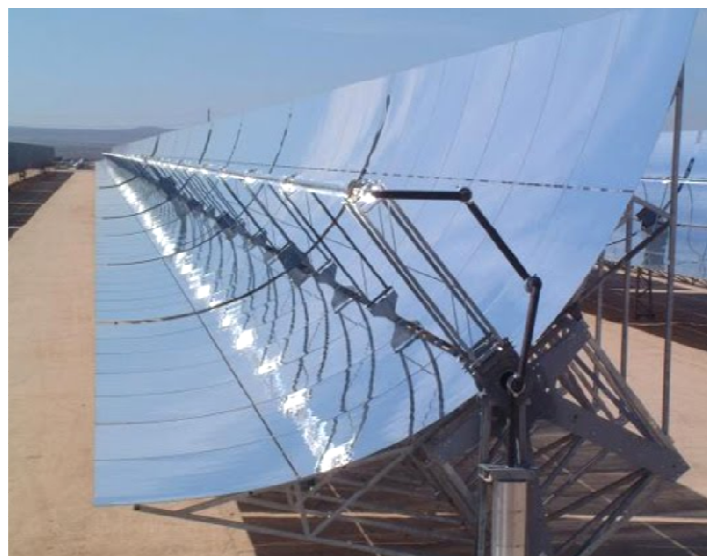
Figura 4. Colector cilindro-parabólico.
