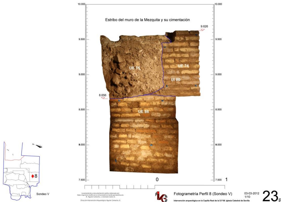
Fig. 4. Composición en fotomosaico de unidades estratigráficas, con valor métrico y textura fotorrealística, a escala 1:10. Las líneas se han trazado entre las interfaces que separan distintas unidades estratigráfica (UE75, UE74 y UE 88).
