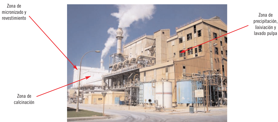
Figura 1.3. Vista parcial de la fábrica Tioxide Europe, S.L. Se han señalado las plantas donde se desarrolla el proceso de precipitación, lixiviación y lavado de la pulpa de \text{TiO}_2 , la zona de calcinación y la zona de preparación del producto final (micronizado y revestimiento)
