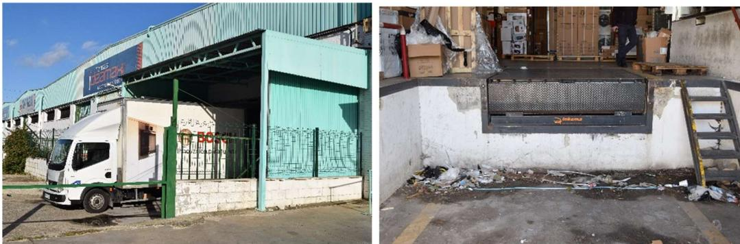
Figura 4-2. Dársenas cubiertas y suelo elevado con muelle hidráulico
