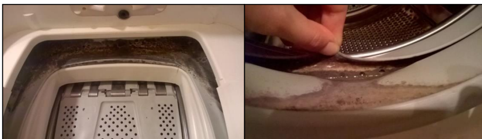
1. ábra: A gombaszennyezettség jellemző kialakulási pontjai a felültöltős (balra) és az előltöltős (jobbra) mosógépekben (a szerző saját felvétele)
