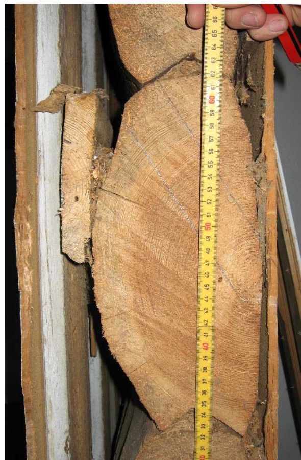
Billede 4: Nedre Urstad, Linnerhaugen (Lindehaug), gnr/bnr 21/1, våningshus. Dørkarmen i stuen er demonteret. Til syne kommer tømmer i form af halvtømmer (figur 4), som daterer til 1728. Foto: Claudia Baittinger.
