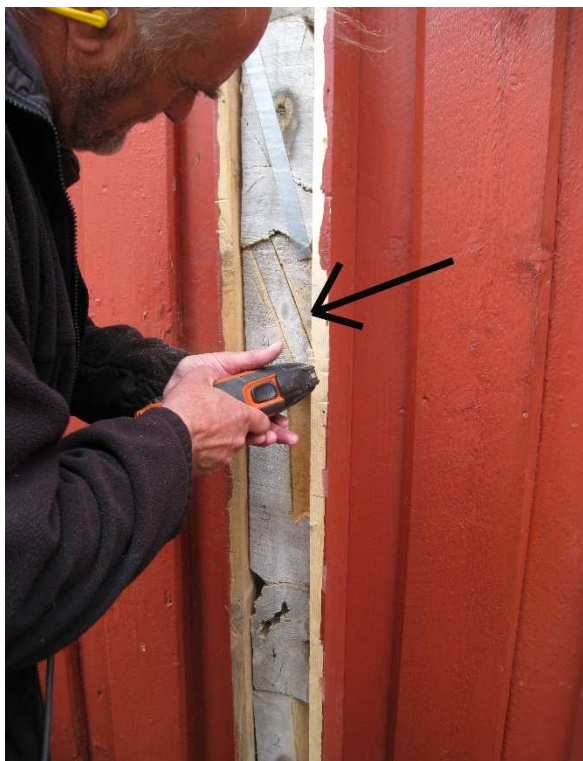
Billede 5: Festevoll, stolpebua, gnr/bnr 12/81. Demontering af den udvendige beklædning. Helge Paulsen er ved at tage en prøve i form af en trekant ved hjælp af en multicutter (pil). Tømmeret daterer til ca. 1800. Foto: Claudia Baittinger.
