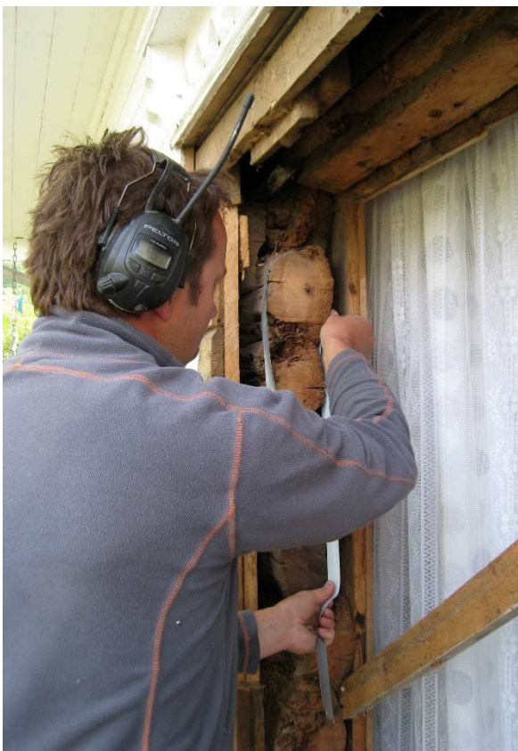
Billede 3: Våningshus fra Vestre Fidja, Tuna (Nygård), bnr/gnr 11/6, hvor vinduesrammen i første etage er blevet fjernet. Christoffer Christensen forbereder udtagning af prøver af rundstokkene i form af skiver. Materialet er i en dårlig bevaringstilstand, men det lykkedes at datere det til ca. 1760. Foto: Claudia Baittinger.
