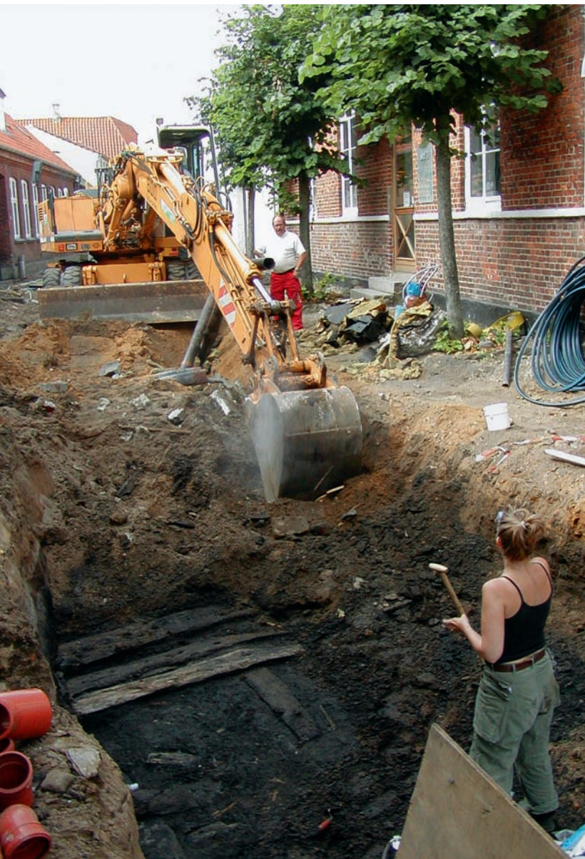
FIG. 16. Udgravning i Sønderportsgade i 2004. Gravemaskinen arbejder med at bortgrave en støbt fjernvarmekanal, mens Mette Højmark Søvsø har fremrenset og registreret en rest plankevej fra 1200-tallet. Sektion for sektion bevæger projektet sig igennem gaden og efterfølgende sammenstykkedes de enkelte registreringer.
