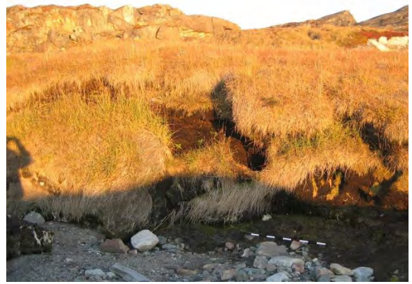
Område ved felt B, 2014 (foto IMG_3669). Blok til venstre i billedet er skredet ned, blok på stranden er flyttet nogle meter mod venstre
